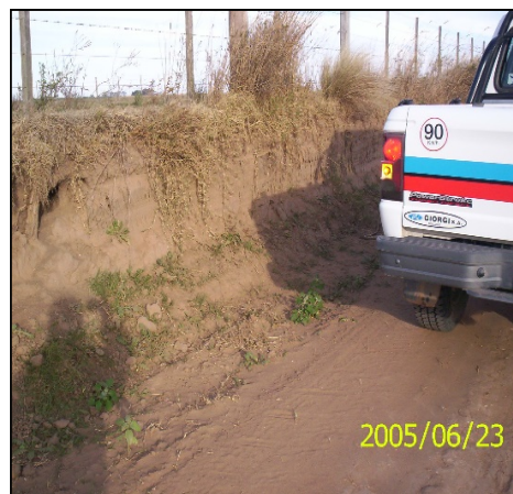
Fig. N°5. Profundización de caminos por erosión hídrica
