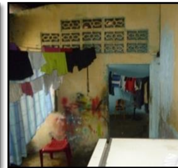
Figura 46. Celosías muros interiores
