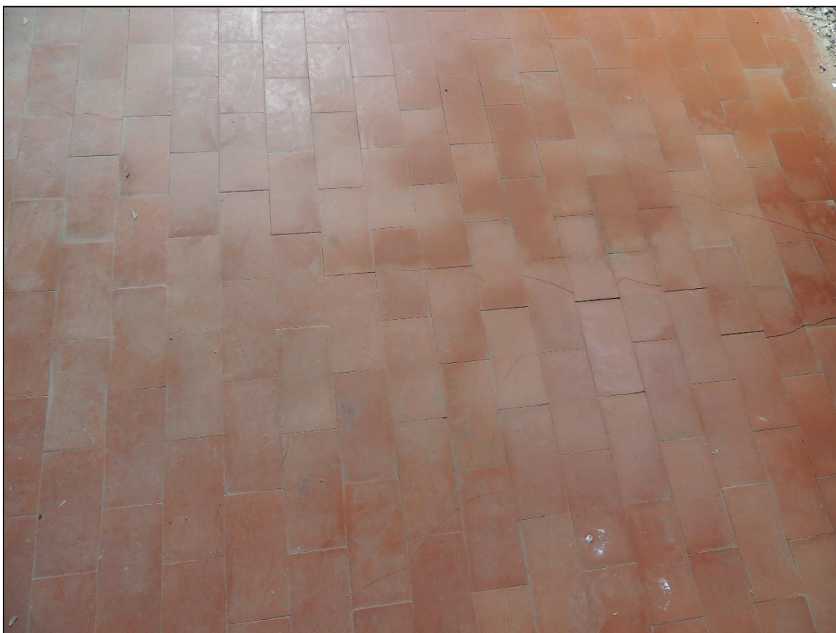
Foto 1 – Piso dos quartos e corredores do Hospital Oswaldo Monteiro (ILHA DA PÓLVORA)
