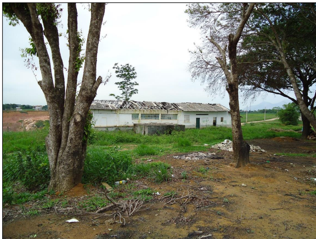
Foto 44 – Prédio da lavanderia em 2010
