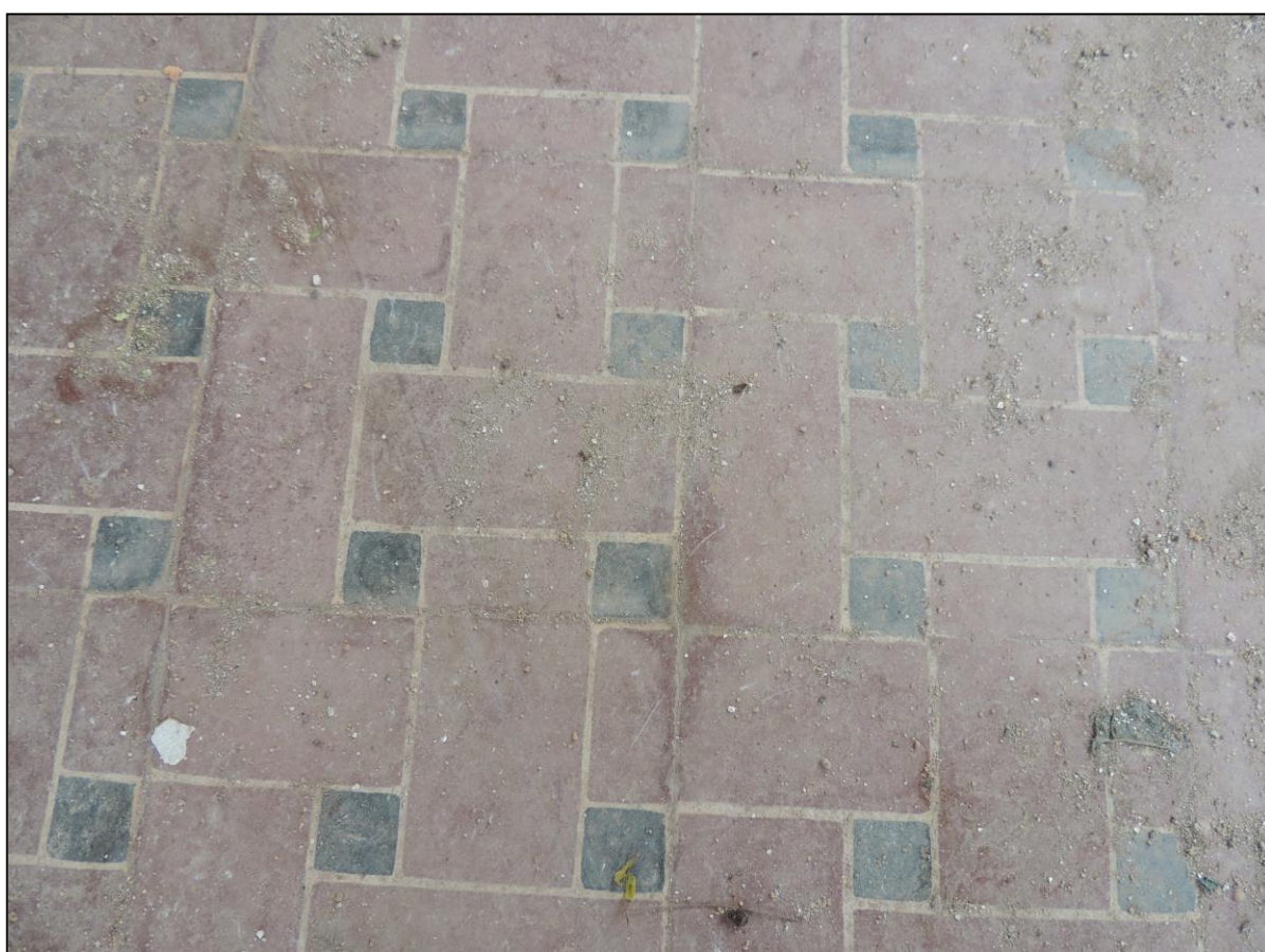
Foto 63 – Piso da parte administrativa do Hospital Oswaldo Monteiro (ILHA DA PÓLVORA)
