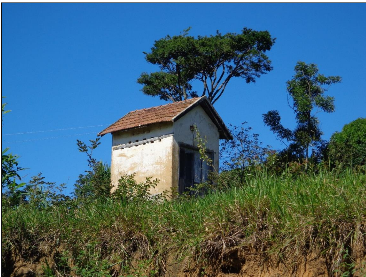
Foto 15 – Casa de Força - 2018
