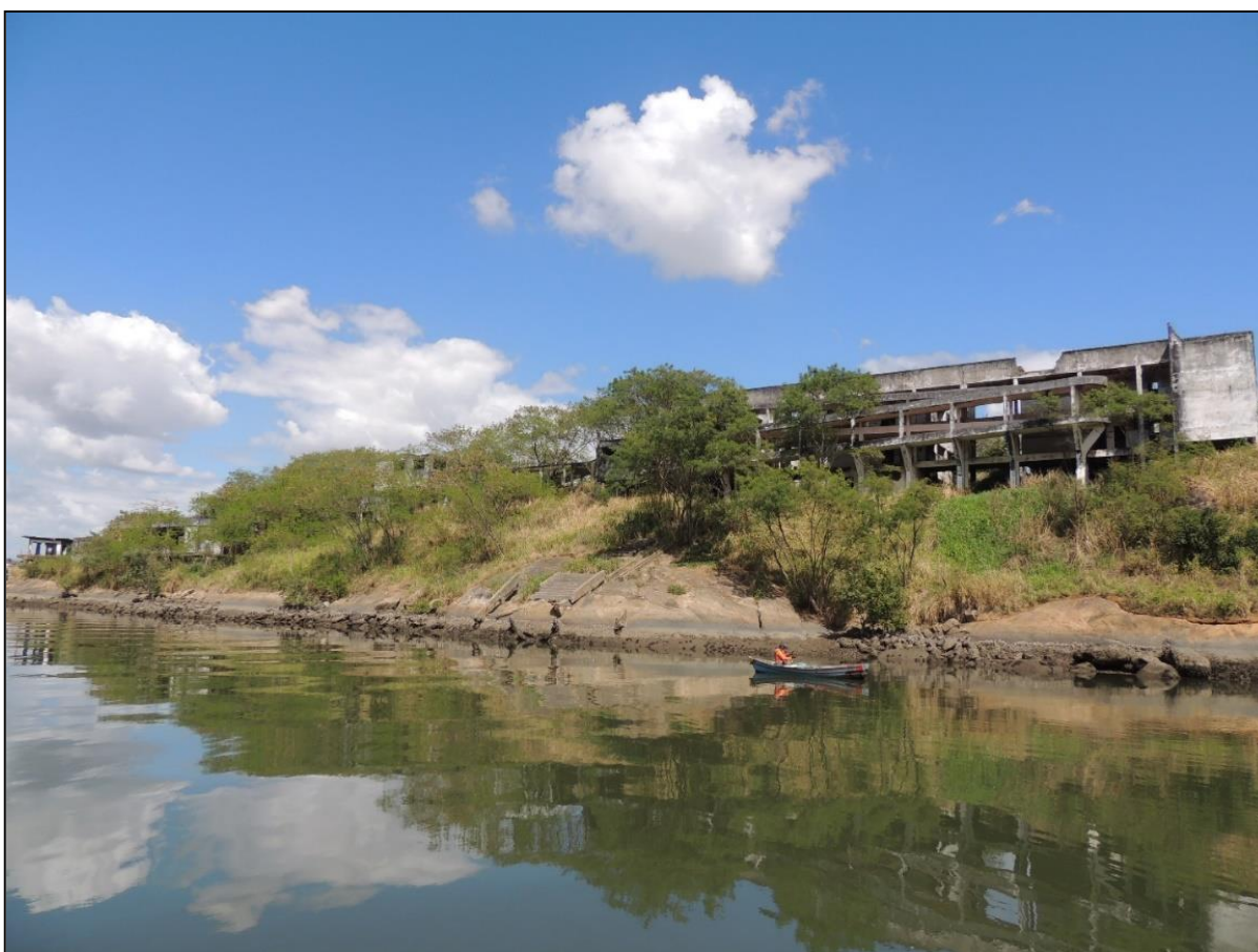
Foto 7 – Hospital Oswaldo Monteiro – Ilha da Pólvora – Setembro de 2018
