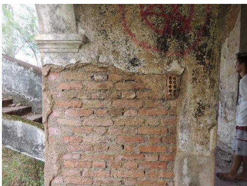
Parede de tijolinho sem reboco.
