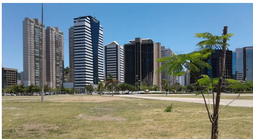
Figura 32. Prédios localizados na Avenida Nossa Senhora dos Navegantes, em frente à Praça do Papa.
