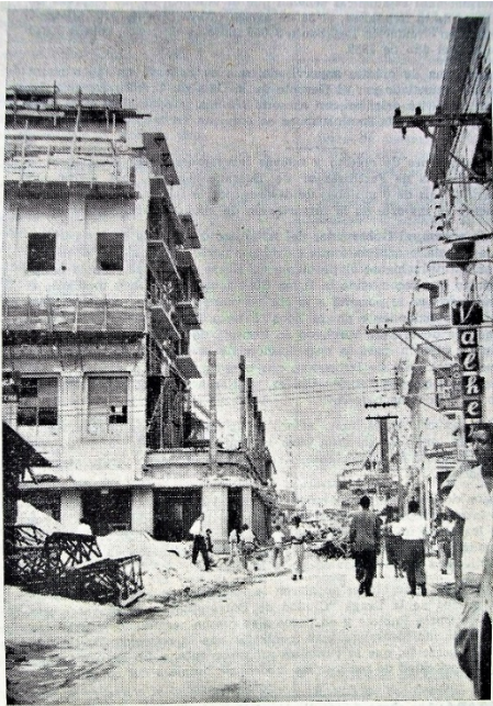
Obras de ampliación de la Avenida 20 de Julio (“Barranquilla progresa” 1959, septiembre 9)
