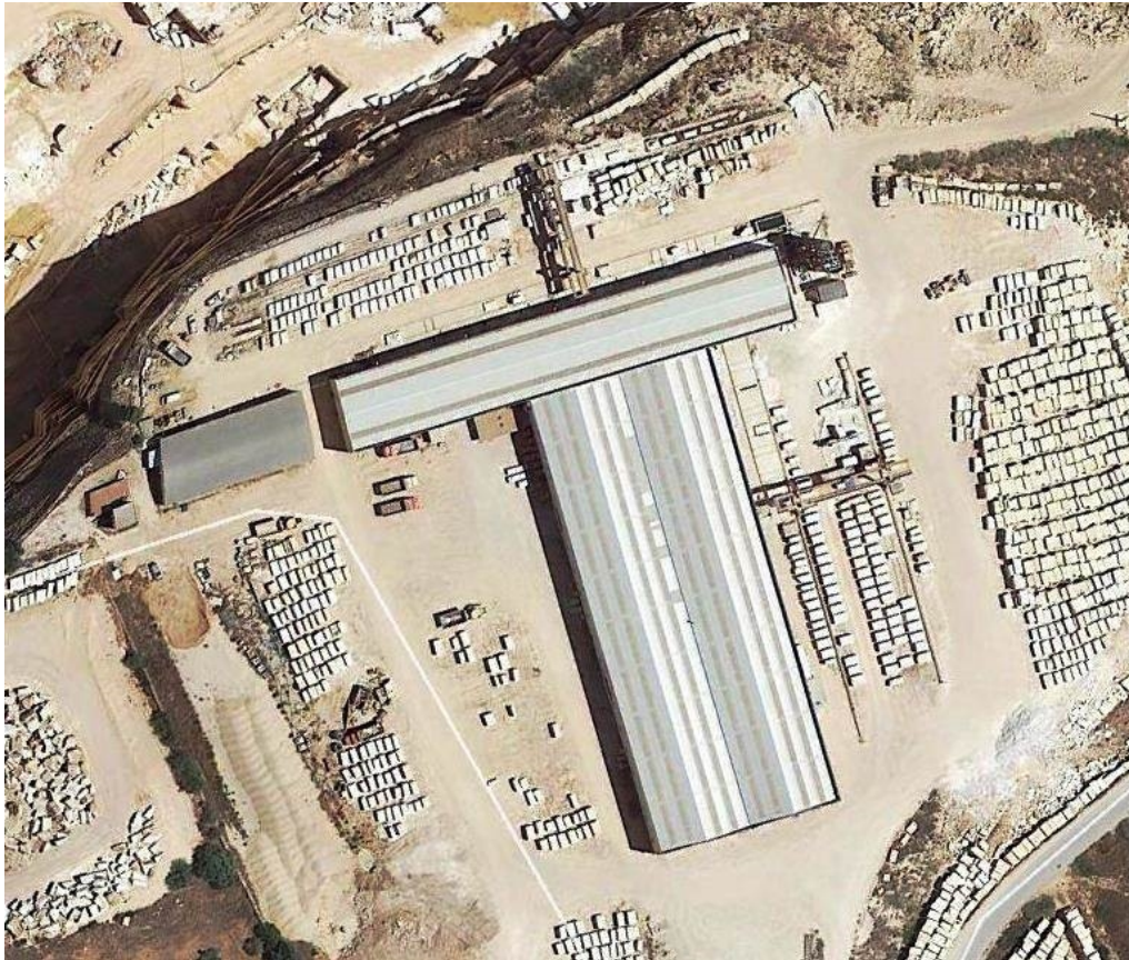
Figura 31 – Ripresa aerea dello stabilimento
