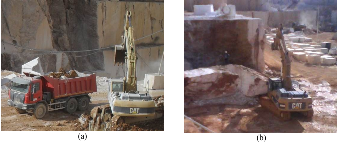
Figura 49 – Escavatore impegnato in operazioni di carico (a) e spostamento dei blocchi (b)
