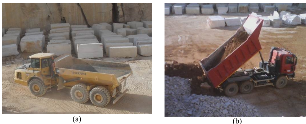
Figura 51 – Dumper in fase di trasporto (a) e autocarro in fase di preparazione del letto di caduta (b)
