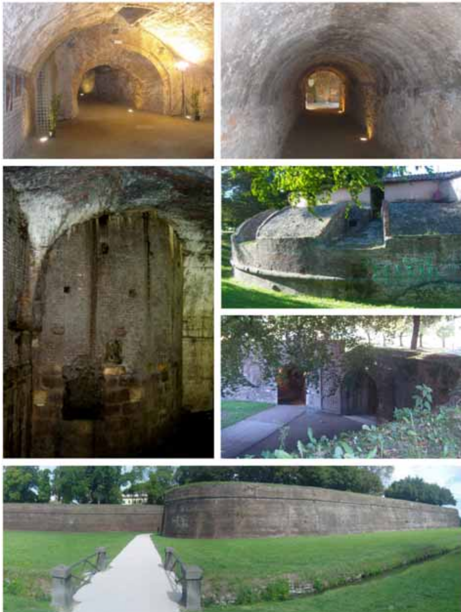
Figura 29: baluardo di San Colombano – collegamenti interni tra le postazioni per artiglieria, particolare dell'innesto del baluardo alla torre circolare cinquecentesca, vista della stessa dall'esterno e dell'orecchione tondo del baluardo.
