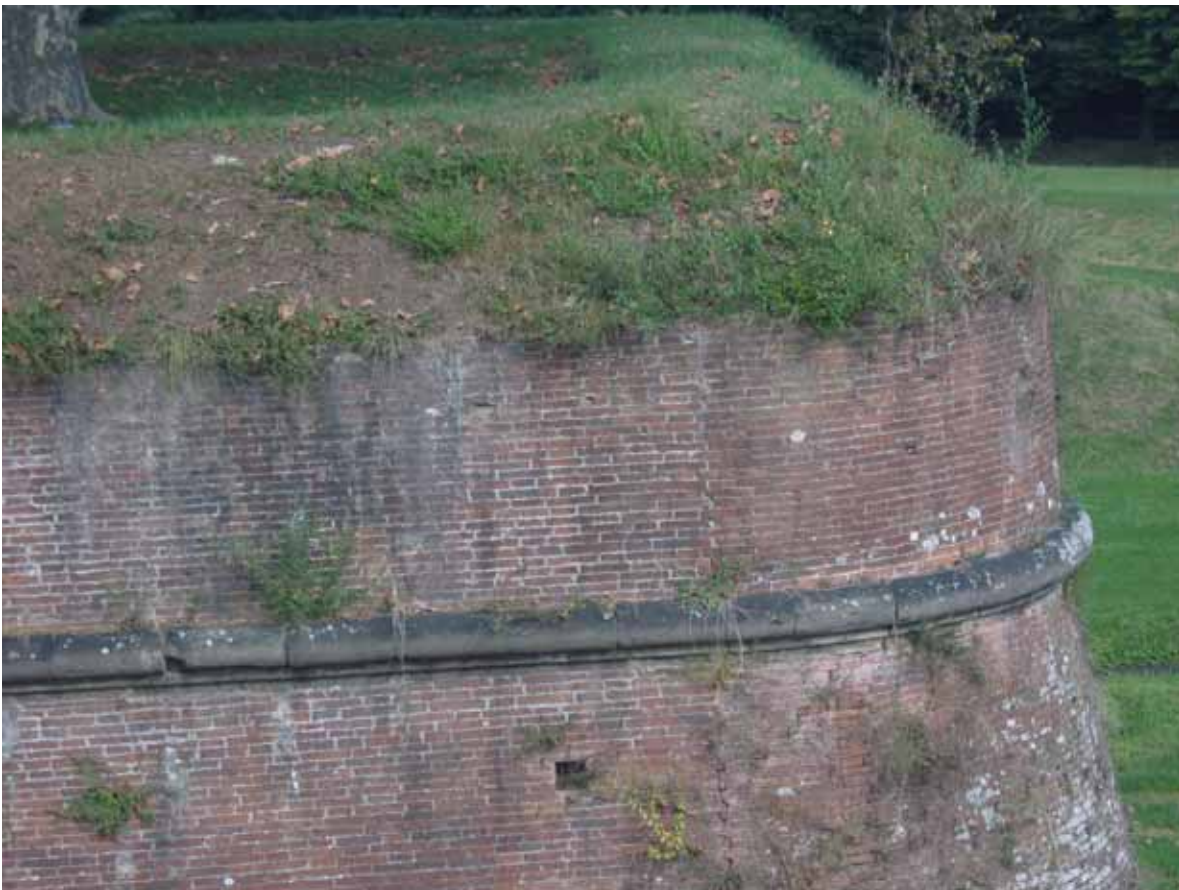
Figura 36: dettaglio del parapetto e cordone dell'orecchione.
