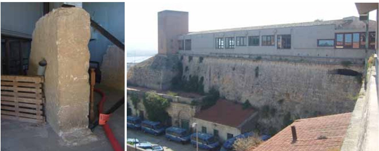
Figura 74: struttura riconducibile alle opere realizzate dal Capellino (spessore del setto pari a cm 60, conforme alle strutture rilevate nel bastione di Santa Croce ed attribuite all'ingegnere cremonese) e vista di una delle due cannoniere dall'esterno.
