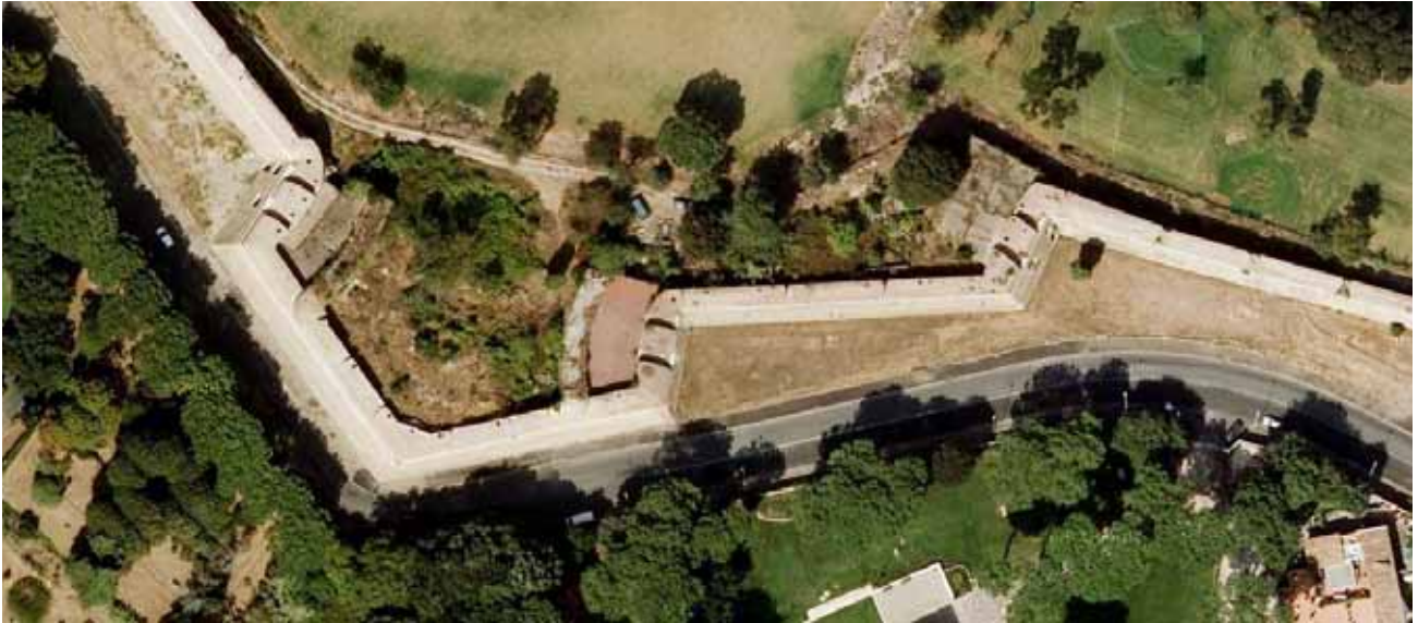
Figura 12: Roma (1537) – Bastione ardeatino opera di Antonio da Sangallo il Giovane (fonte: http://maps.google.it ).
