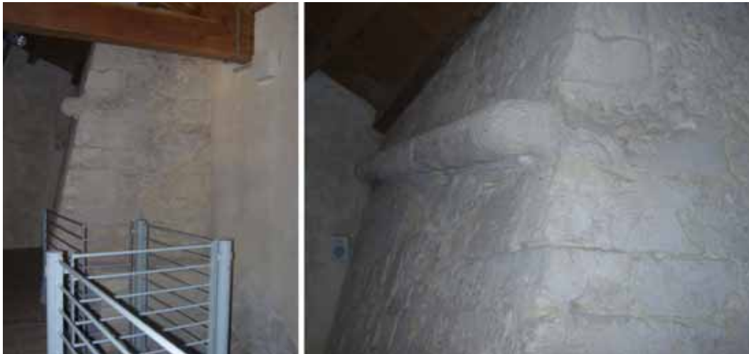
Figura 63: segmento del bastione di Santa Croce rilevato (tratto 5 della Fig. 61).
