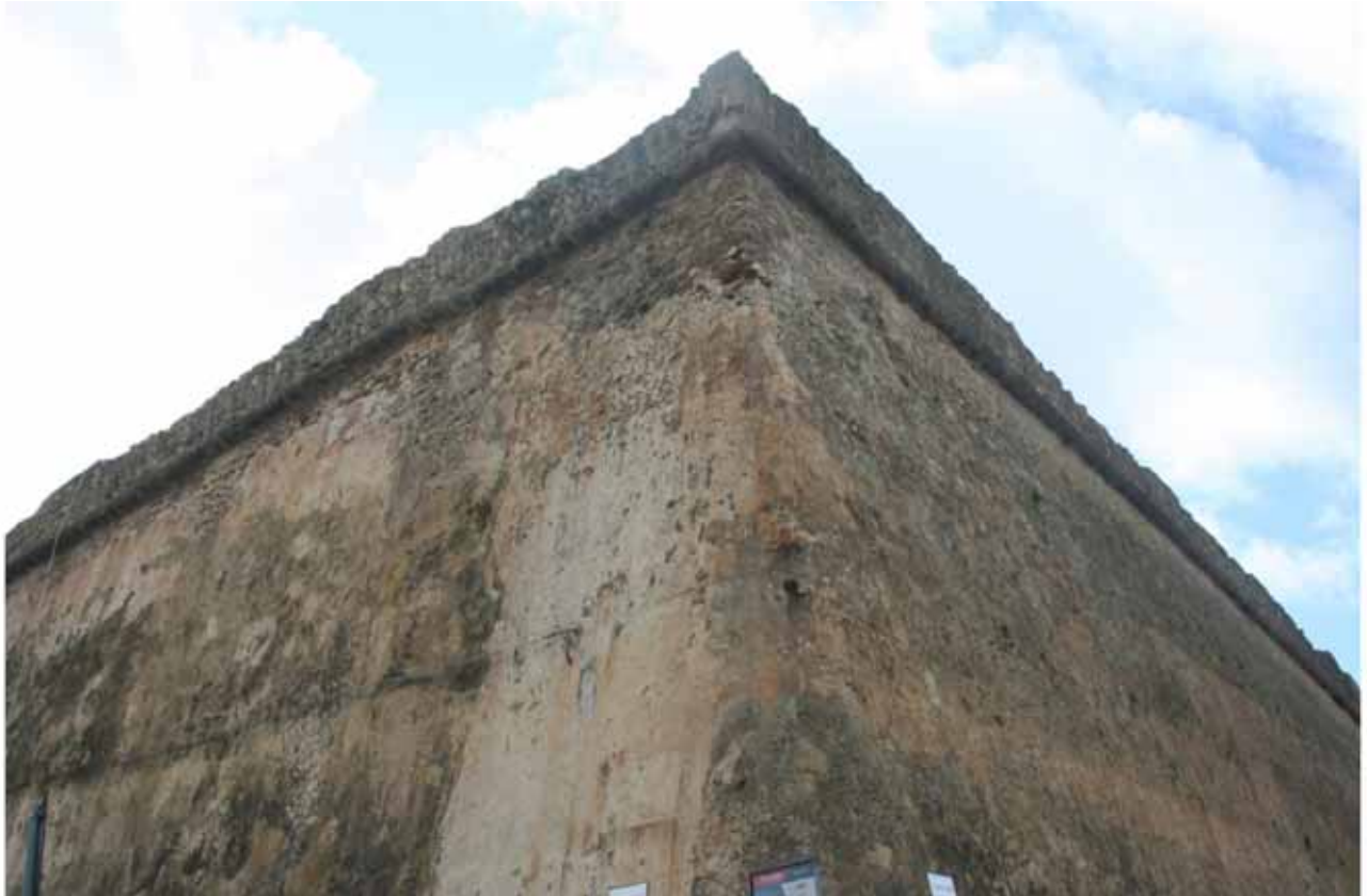
Figura 55: Alghero - parapetto verticale nel baluardo della Maddalena.
