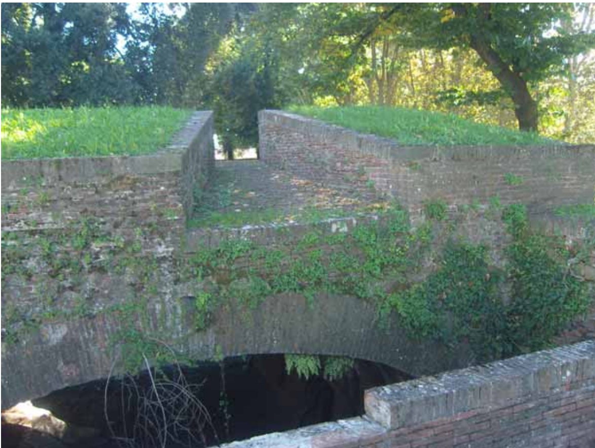
Figura 34: dettaglio delle troniere nel baluardo La libertà.
