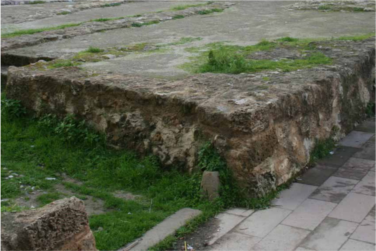
Figura 68: dettaglio della porta di soccorso e della scarpa del bastione di Montalbano.
