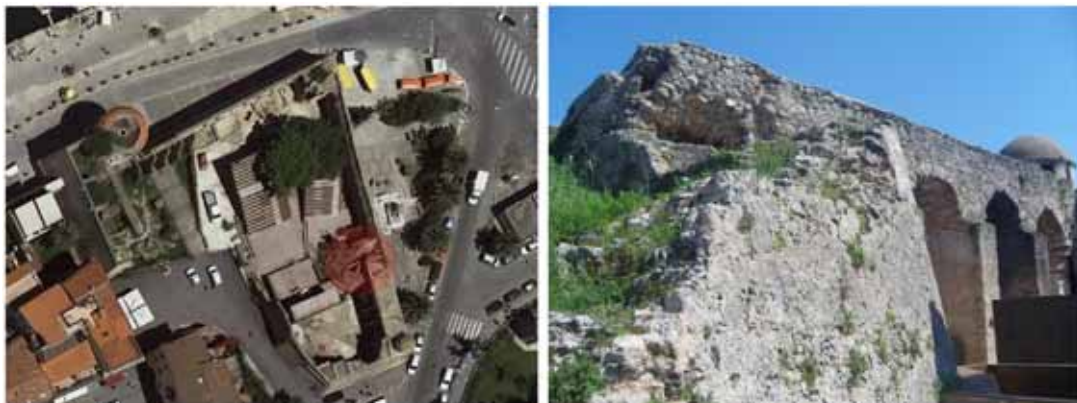
Figura 26: alcune immagini del baluardo della Maddalena realizzato nel periodo 1552-1573 (immagine aerea del baluardo - fonte: www.sardegna territorio.it/wegis/fotoaeree/index.html ).
