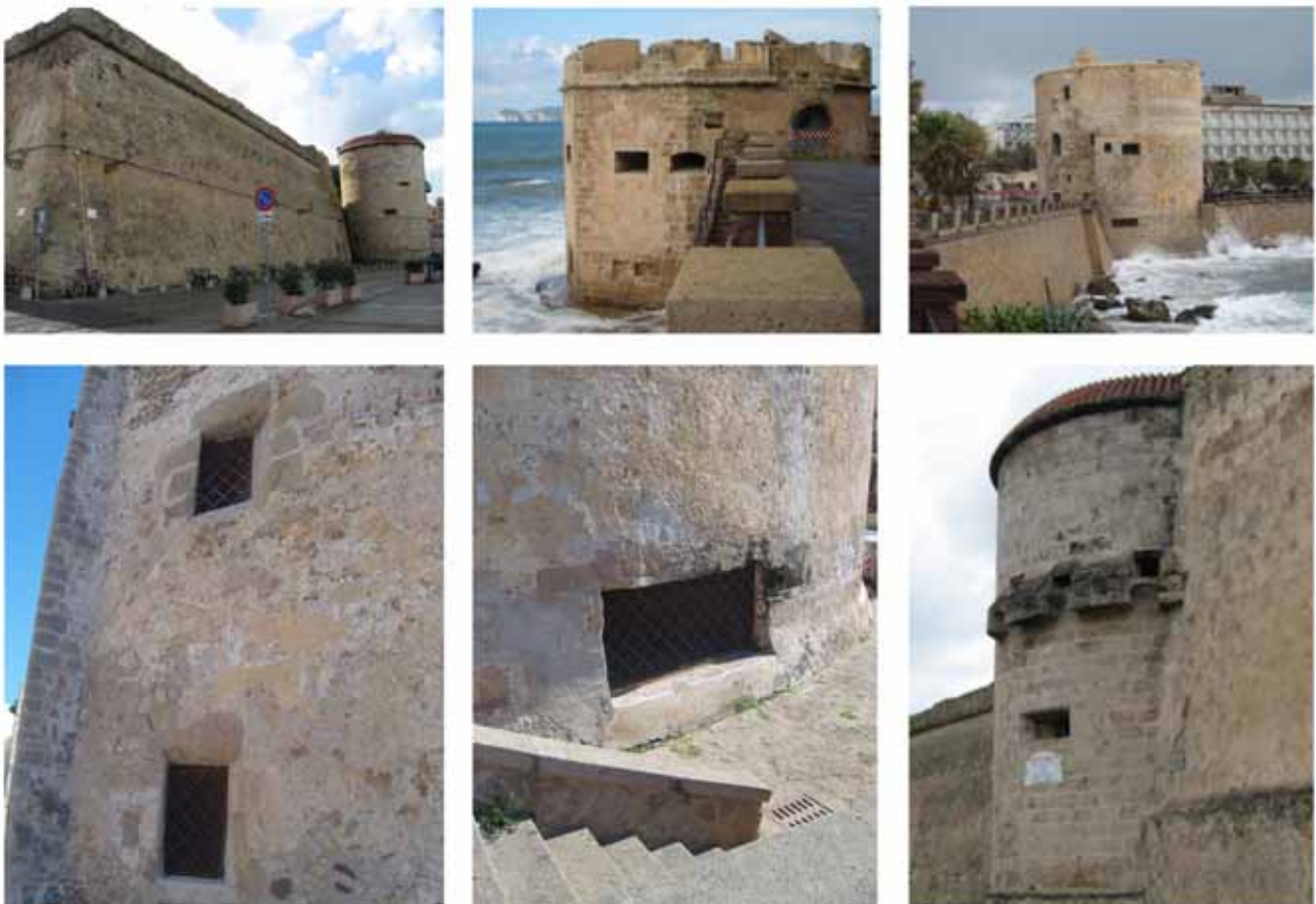
Figura 18: postazioni per l'artiglieria a difesa dei fianchi dei baluardi (viste d'insieme e di dettaglio). Si individuano da sinistra verso destra e dall'alto verso il basso, la torre e bastione della Maddalena, la torre di San Giacomo, la torre dello Sperone, le postazioni presenti nella torre di San Michele (due immagini) e nella torre della Maddalena.
