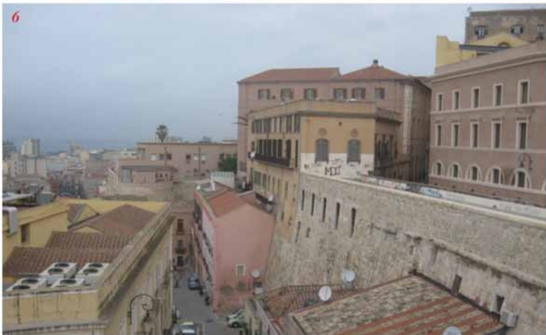
Figura 68: viste d'insieme e dettagli (mensola di appoggio della garitta e vista della cannoniera) del baluardo della Leona (1-5), fianco con orecchione tondo del baluardo del Balice e cortina di collegamento tra i due baluardi (6).
