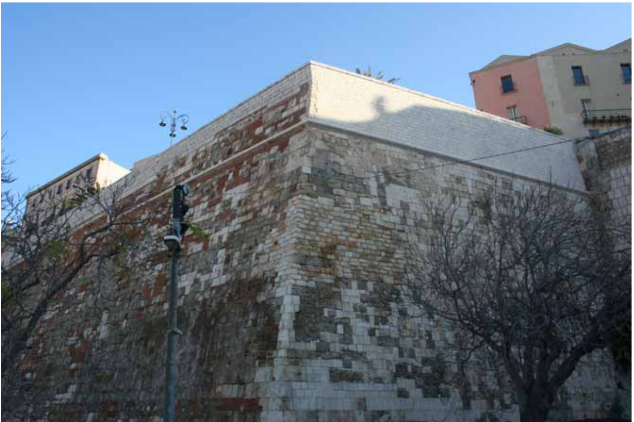
Figura 7: tratto progettato da Giorgio Palearo nel 1575. Nonostante la presenza di numerosi restauri è ben visibile l'inclinazione del parapetto 15 .
