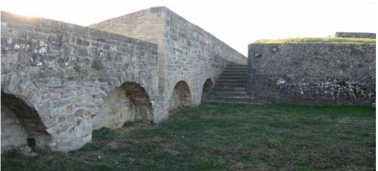
Figura 47: rampa di collegamento tra le diverse quote del baluardo.
