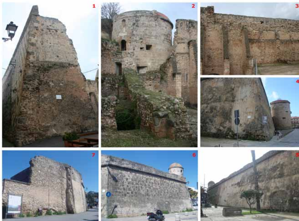
Figura 73: Bastione della Maddalena: fianco ovest (1), punto d'innesto della cortina cinquecentesca alla torre (2), dettaglio della parete interna e tracce dei setti (3), prospetto esterno a partire dalla Torre della Maddalena per giungere alla spalla del fianco ritirato (4-5-6-7).
