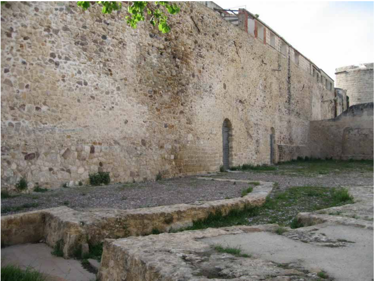
Figura 63: "rasature" del bastione di Montalbano.
