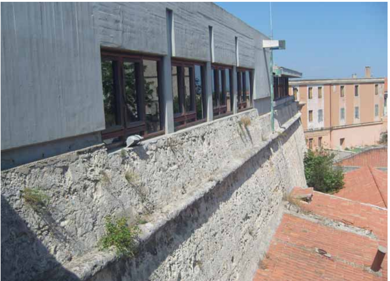
Figura 11: vista di dettaglio del parapetto inclinato 16 .
