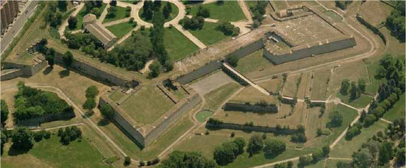
Figura 40: vista della cittadella (fonte: http://maps.google.it ).
