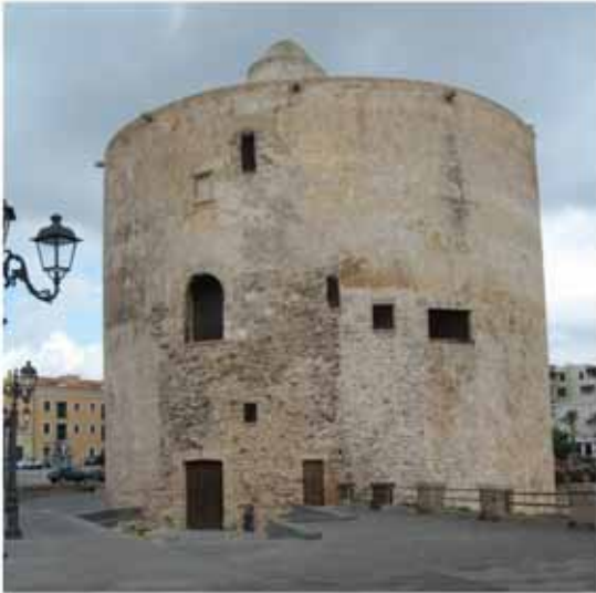
Figura 30: Alghero - Torre dello Sperone (vista d'insieme di scarpa e cannoniera).
