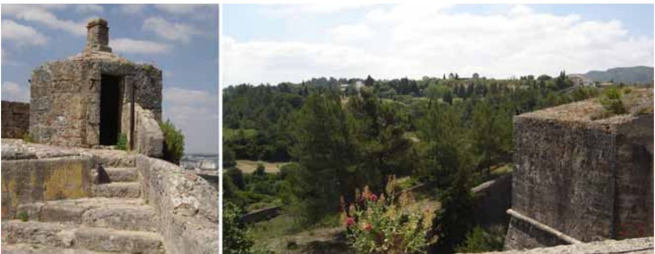
Figura 18: dettagli architettonici della fortezza (scarpa, cordone e parapetto del baluardo e garitta).
