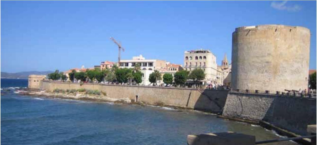
Figura 53: torre dello Sperone e torre di San Giacomo
