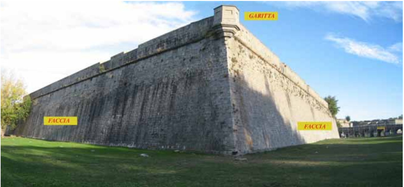
Figura 49: La cittadella di Pamplona in Spagna (baluardo con fianchi ritirati e spalla a musone).
