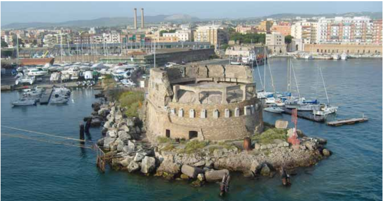
Figura 16: Civitavecchia – torre cinquecentesca con struttura in conglomerato e camicia esterna in mattoni.
