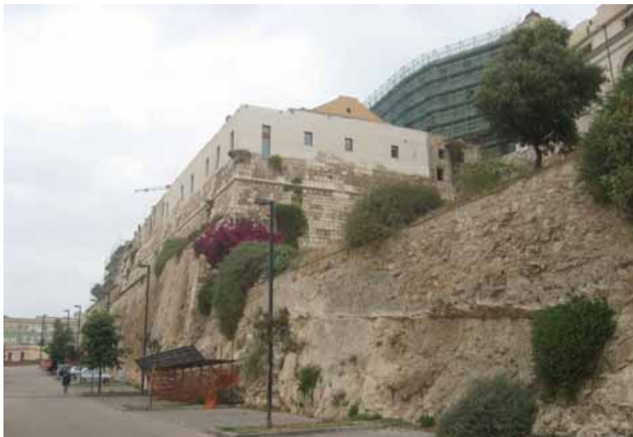
Figura 64: faccia ovest e fianco sud del bastione di Santa Croce opera del Capellino.
