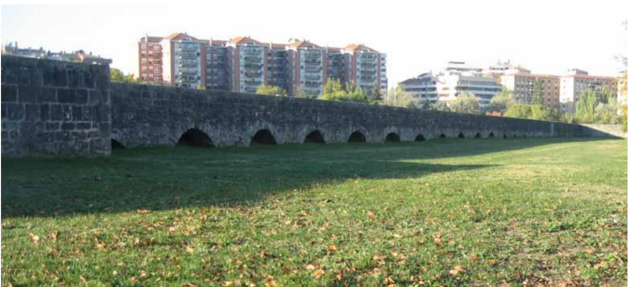
Figura 45: vista della successione degli archi di collegamento della struttura di contenimento del terrapieno 31 .
