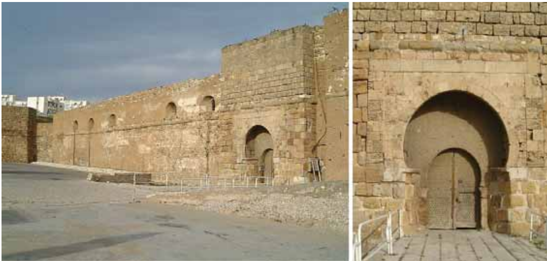
Figura 36: Il forte della Goletta di Tunisi - interventi di restauro eseguiti dai Turchi dopo la conquista del 1574.
