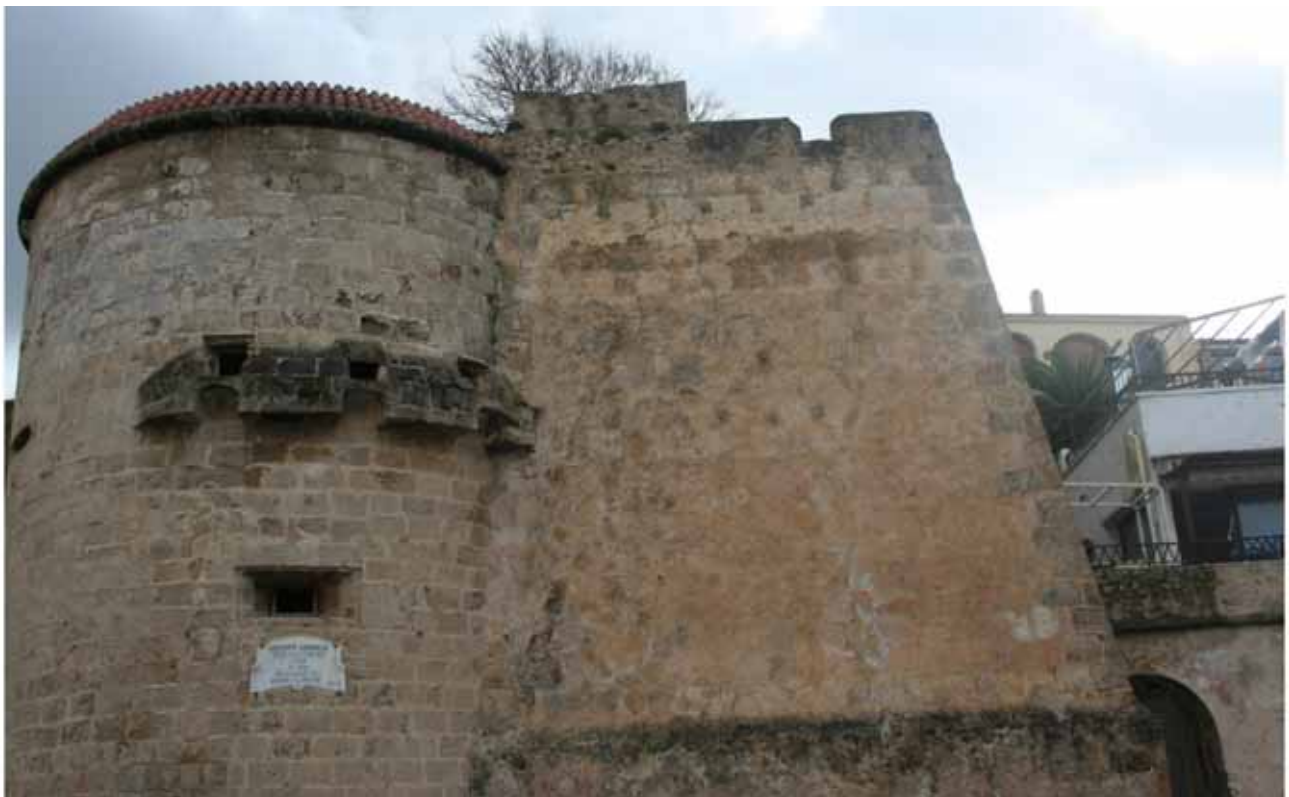
Figura 56: punto di contatto tra torre (con funzione di orecchione) e baluardo della Maddalena e parapetto inclinato 79 .
