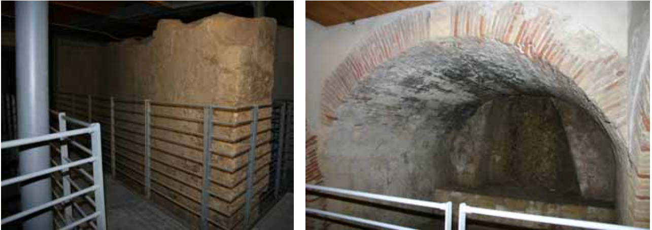
Figura 62: bastione di Santa Croce – setti murari riferibili all’opera del Capellino (con dimensioni dei setti 46 e distanza tra di essi conformi alla soluzione adottata dall’ingegnere cremonese per la realizzazione della Tenaglia di San Pancrazio) e strutture voltate di epoca successiva.
