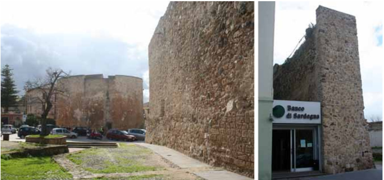
Figura 64: vista della cortina (altezza media di 11 metri e spessore 3,80 m) e della torre cinquecentesca di San Michele.
