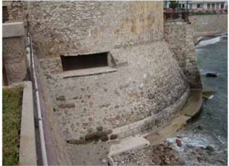
Figura 30: Alghero - Torre dello Sperone (vista d'insieme di scarpa e cannoniera).
