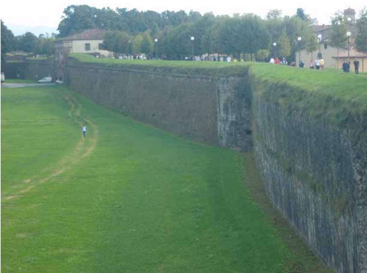
Figura 35: raccordo tra perimetro bastionato e muro medievale (cortina ripiegata con postazione per artiglieria).
