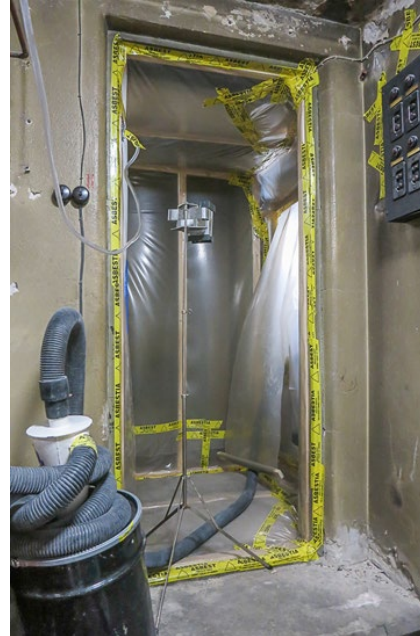
Kuva 2. Osastoinnin eteistila, jossa oikealta kulku sulkutunneliin. Kuvassa keskellä mittauspiste.
