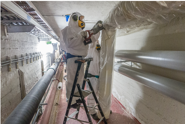
Kuva 7. Massaeristeen purkua puukkosahalla, toisella työntekijällä imuri sahauskohdan läheisyydessä. Purettava eriste pussitettu.
