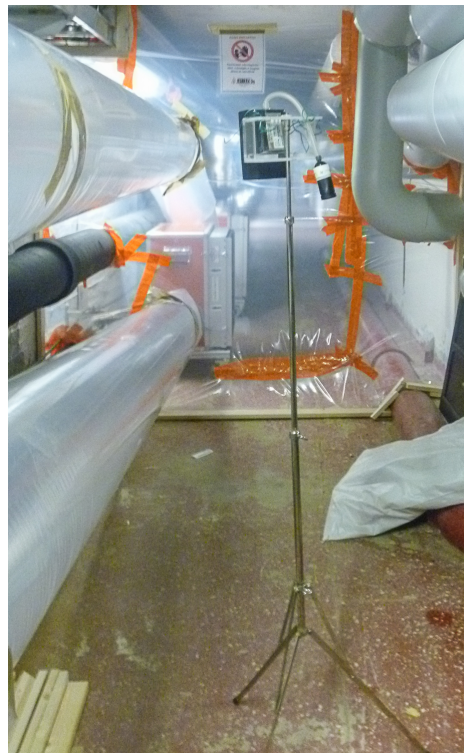
Kuva 2. Mittauspiste osastoinnin ulkopuolella. Osastoiva seinärakenne: muovikalvot, puurimat ja rajapintojen tiivistysteippaukset.
