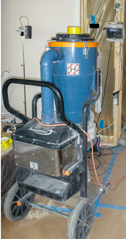
Kuva 2. Sulkutunnelin läppäovirakenne ja korvausilma-aukko (noin 100 cm 2 ). Osastoinnin sisällä käytetty imuri sijoitettu osastoinnin ulkopuolelle. Vasemmalla mittauspiste huoneistossa.
