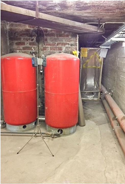
Kuva 3. Osastoinnin ulkopuolella sijaitseva mittauspiste. Sulkutunneliin kulku.
