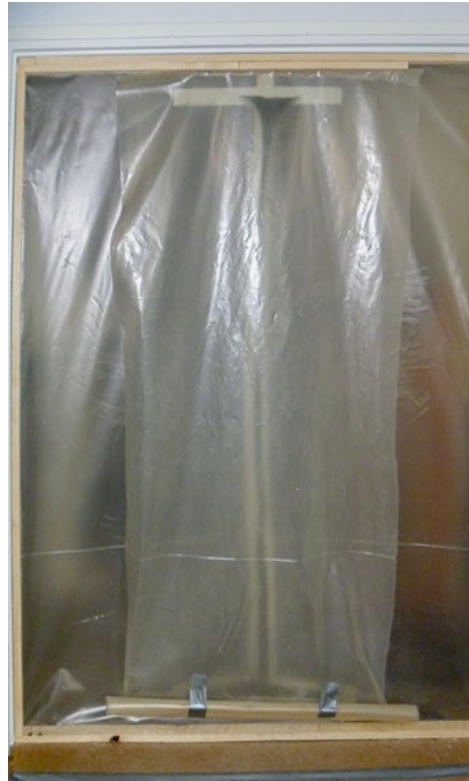
Kuva 4. Lämpövirakenne jätteiden varastointitilan edessä.
