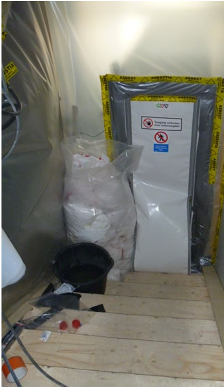
Kuva 3. Sulkutunnelin edusta osastoinnin sisäpuolella.
