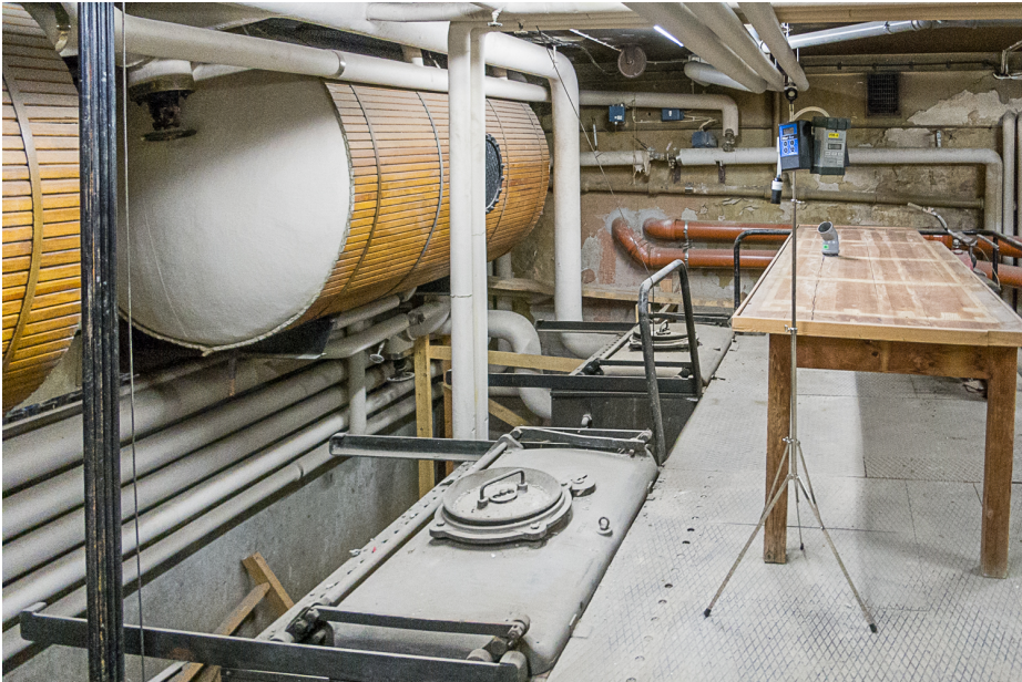
Kuva 5. Mittauspiste kattila-/lämmivesivaraajahuoneessa osastoinnin ulkopuolella kauempana lämmönjakuhuoneesta.
