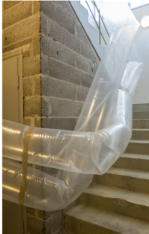
Kuva 4. HEPA-suodatetun ilman johtaminen muovisukkien avulla ulos. Kanavassa taitekohtia.
