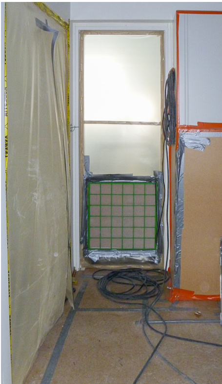
Kuva 1. Osastointi muovikalvoin. Alipaineistuslaite asennettu suojaseinään (kuvassa imupuoli osastoinnin sisäpuolella).
