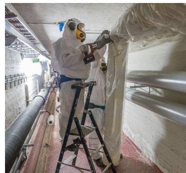
Säkitetyn massaputkieristeen purku parityöskentelynä käyttämällä imuria kohdepoistona eristeen leikkauskohdassa.
