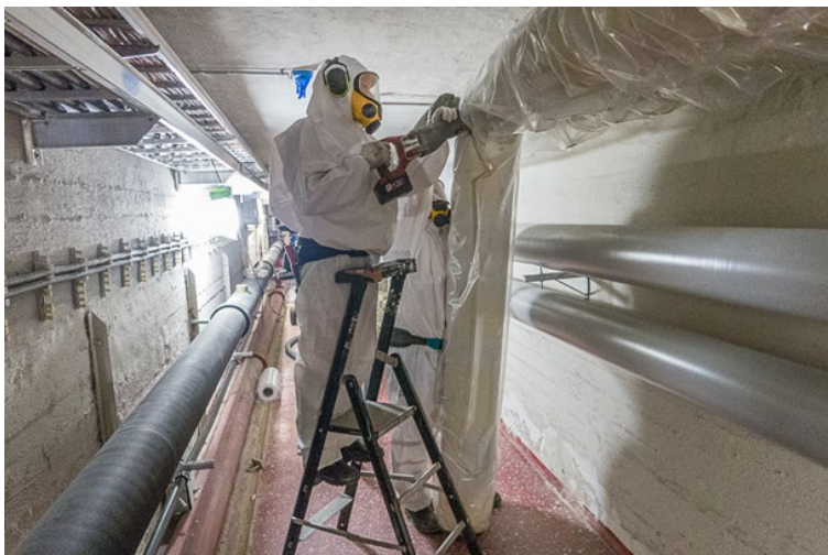
Kuva 1. Massaputkieristeen purkua.
