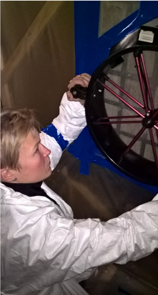
Kuva 7. Alipaineistajan ilmavirran mittaus Accubalancella.
