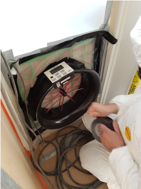
Kuva 8. Alipaineistajan ilmavirran mittaus Accubalancella.
