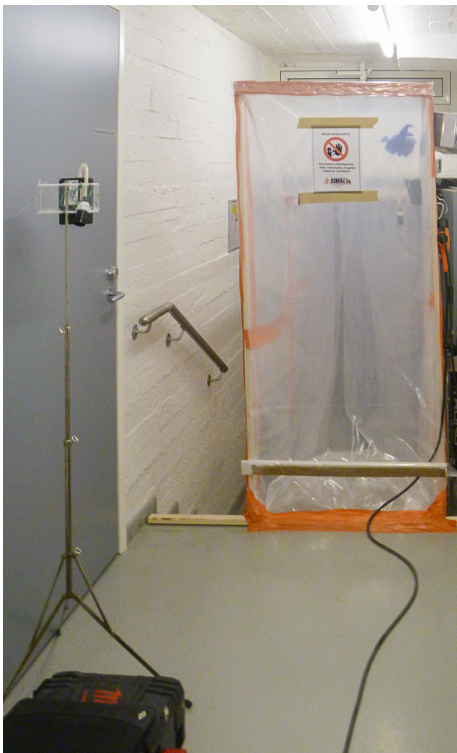
Kuva 1. Osastointiin johtava kolmiosainen sulkutunneli, jossa läppäovirakenne. Mittauspiste sulkutunnelin edessä.
