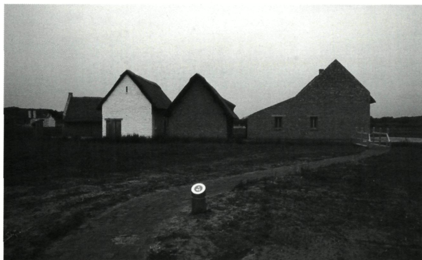
1 The reconstructed houses of 'Walraversijde 1465' De gereconstrueerde huizen van 'Walraversijde 1465'
