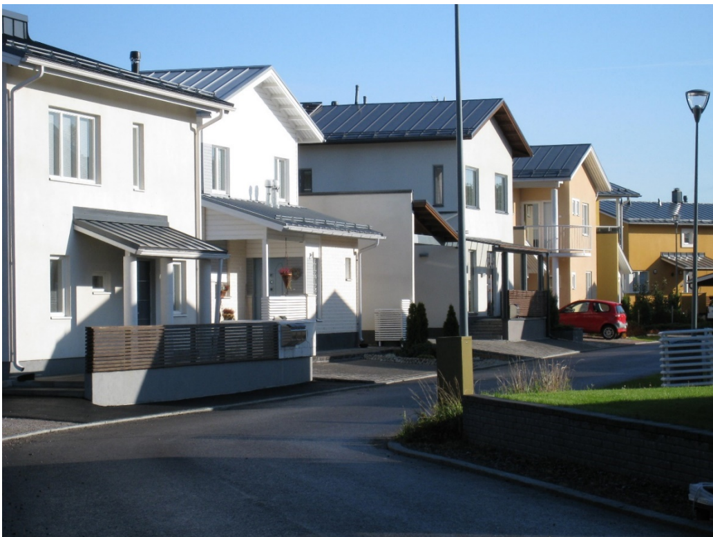
Esimerkkejä Muotialassa toteutetuista suunnitteluratkaisuista, kuten aidatuista pihoista ja tiivistä sekä matalasta rakentamisesta. Kuvat: Hilikka Lehtonen (ylempi), Marketta Kyttä (alempi).
