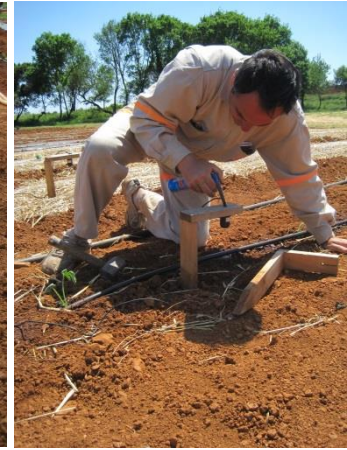
Slika 45. Postavljanje drvene konstrukcije za FAR senzor, 5. svibnja 2011.
