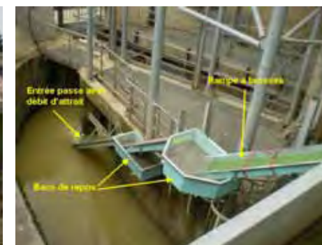
Passé à anguille de l'usine de Golfech (Garonne). Détail de la passe aval. © F. Travade EDF
