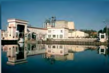
Centrale hydroélectrique - vue amont - © P. Gomes
