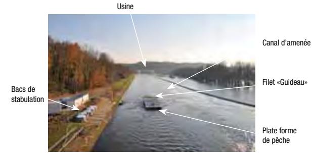
Vue du canal depuis l'amont © ECOGEA
