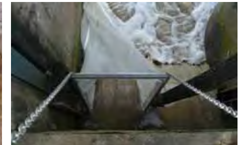
Dispositif de filtration des entrées par surverse. Relevé toutes les 15 minutes au cours de l'envoi - © P. Baran
