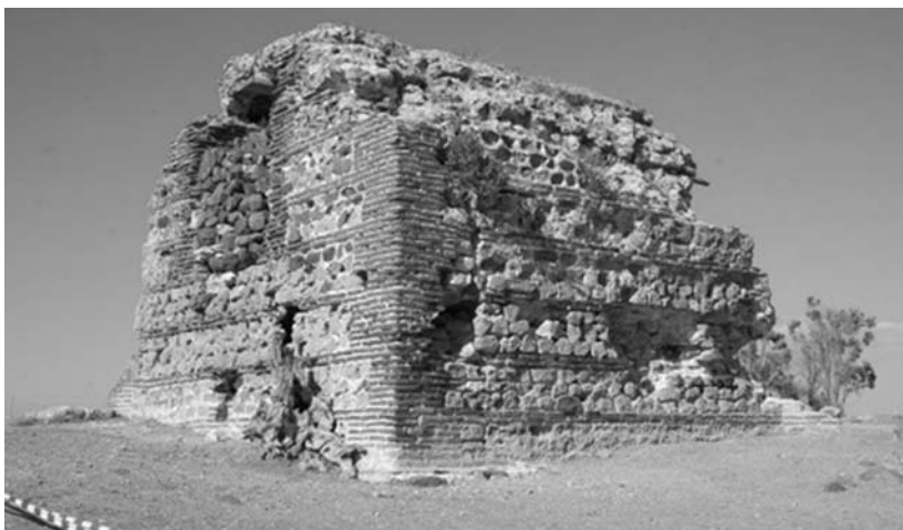
Fig. 9: Prospetto esterno ovest della vasca nord-occidentale del frigidarium delle “Grandi Terme”.
