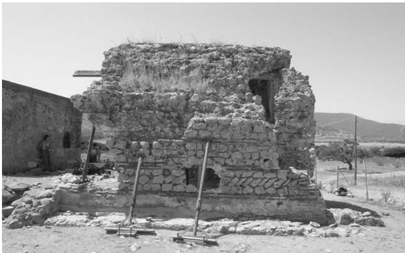
Fig. 8: Prospetto esterno nord della vasca nord-occidentale del frigidarium delle “Grandi Terme”.
