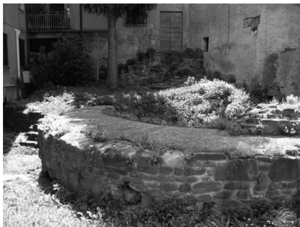
Fig. 3: I resti di vicolo Aurigemma nella sistemazione attuale.
