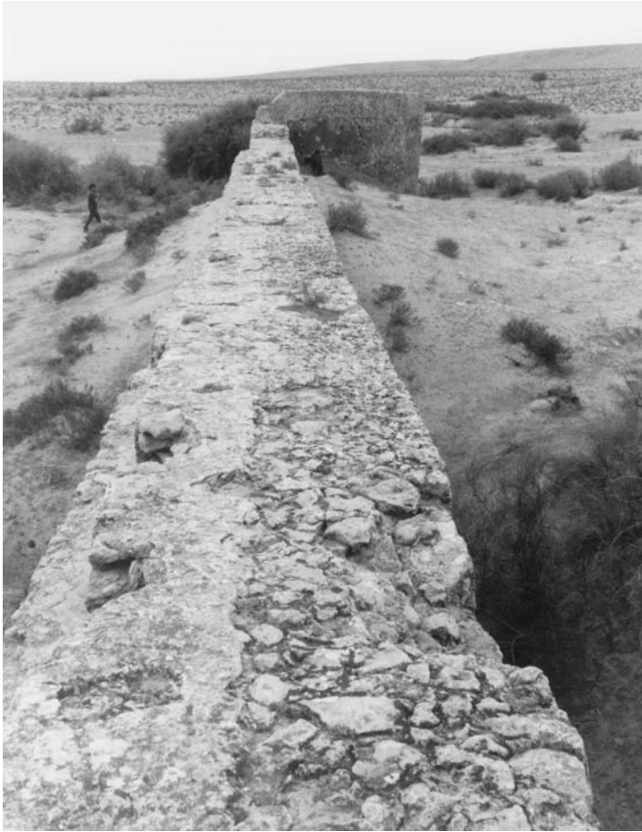
Fig. 4: Sbarramento idraulico (TRG 90) nel wadi Taraglat.
