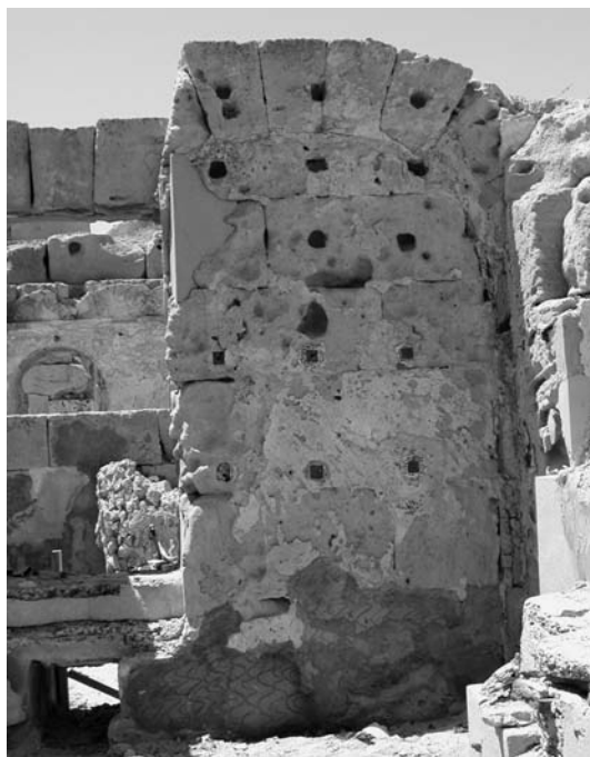
Fig. 9: Il muro sud del calidarium .
