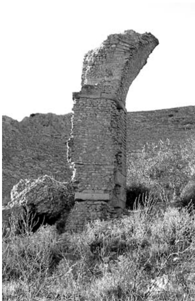
Fig. 6: Pagus Suttuensis , pilastro di un edificio connesso all'acquedotto (foto A. Gavini).
