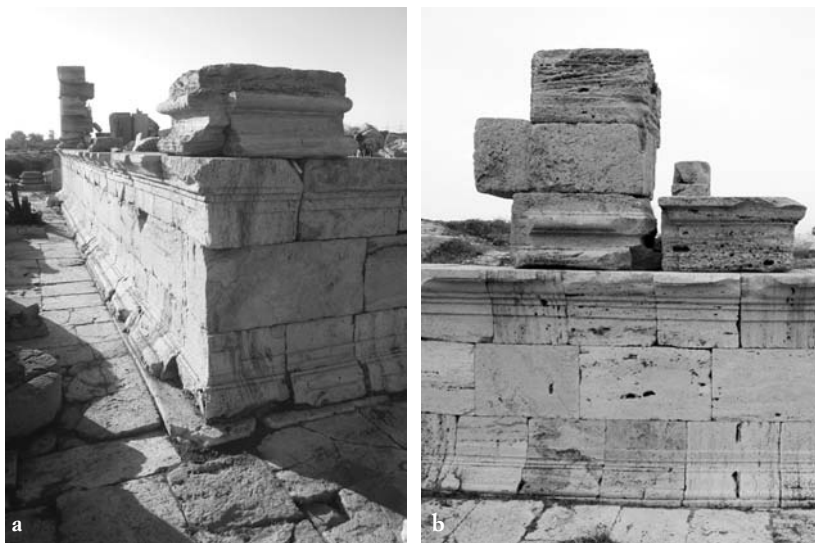
Fig. 10, a-b: Edificio centrale della Curia: a) veduta dell'angolo posteriore del podio; b) particolare del pilastro angolare ovest della fronte e del capitello d'anta (foto M. Livadiotti, 2008).
