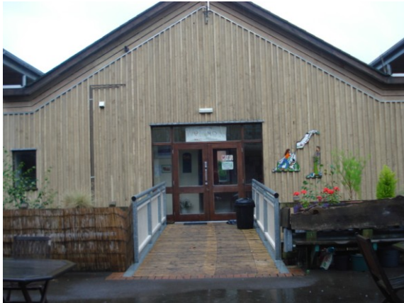
Fotografie 25. Edificio comune
