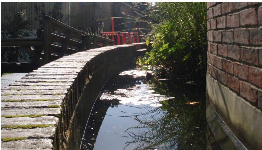
Fotografia 31. Canale di scolo dell'acqua
