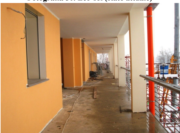
Fotografia 52. Ballatoio (stato attuale)
