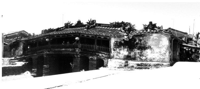
Fig.3-Hoi An, il ponte giapponese, oggi Foto: M.Marchi
