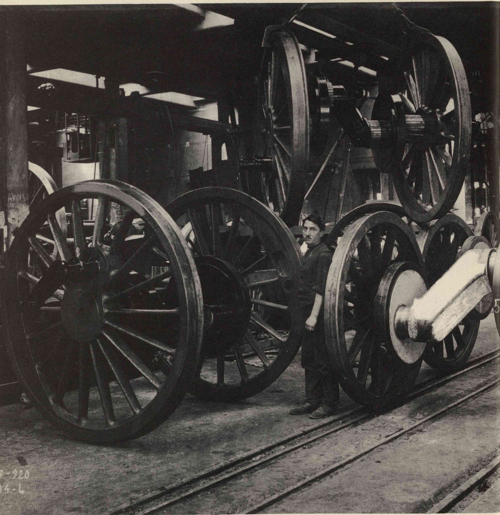
1920. Deposito delle sale montate a gomito con manovella e contromanovella. A destra: controllo di una sala montata.
