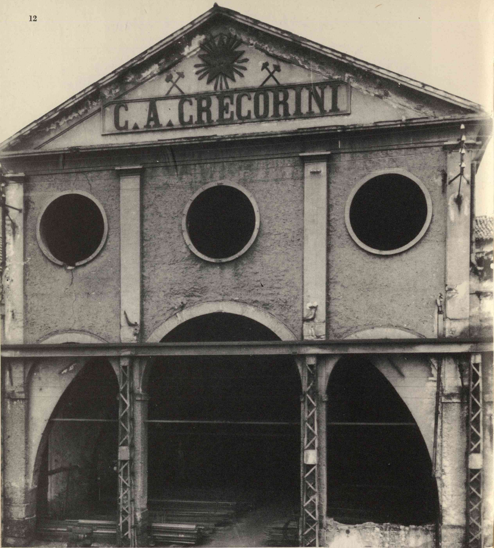
Il nucleo centrale dello stabilimento G.A. Gregorini ove erano installati due altiforni a carbone di legna.
