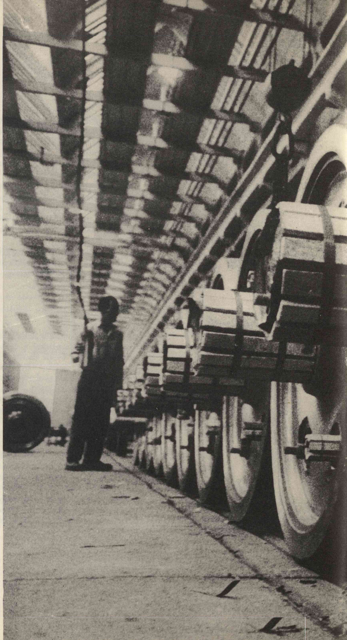
Sale montate per locomotive elettriche pronte per la spedizione.
