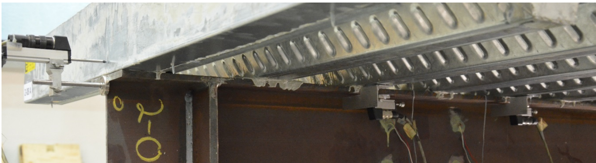
Abb. 4-46: Schlupfmessungen zwischen Betongurt und Stahlträger
