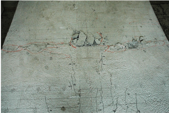
Abb. 4-62: Betonversagen Betonoberseite Schubträger S2 (teilweise verdübelt), aus [74]
