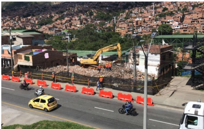
Figura 43. Demoliciones en el barrio la Paralela
