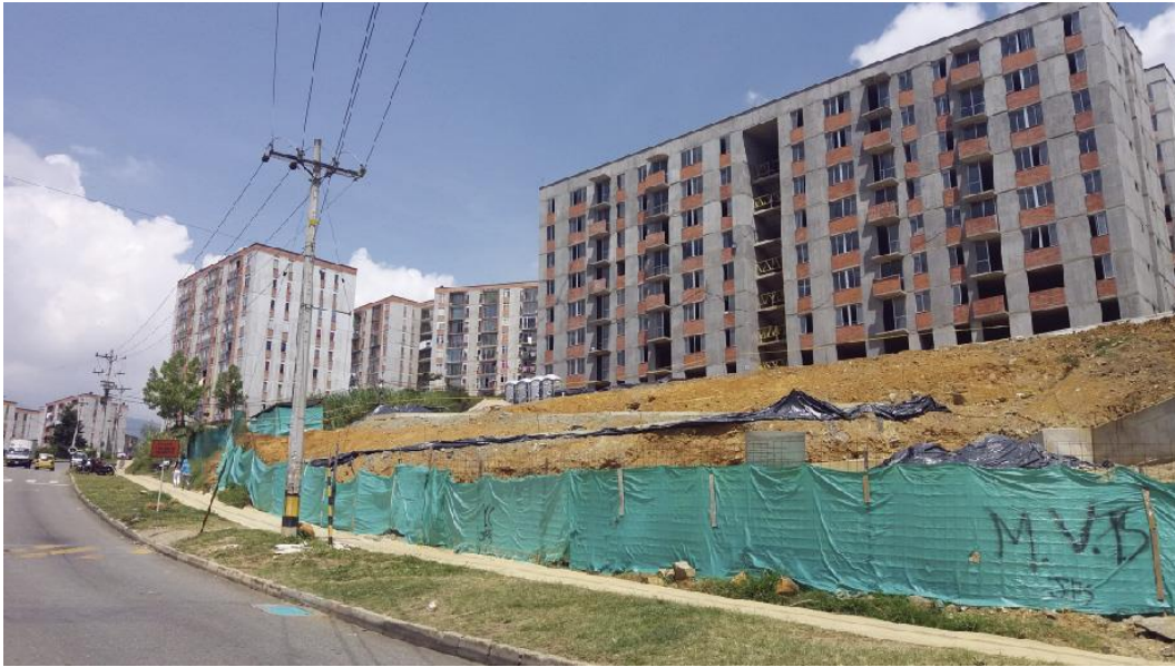
Figura 3. Etapa sin terminar, destinada a los locales comerciales.
