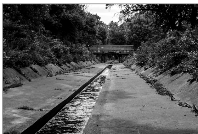
Fot. 6. Betonowy żłób Jasienia. W oddali ceglany most przy ul. Cieszkowskiego. Fot. J. Jędruszkiewicz
