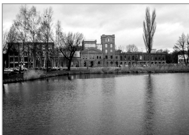
Fot. 4. Siedziba ŁSSE w siłowni d. zakładów Grohmana Fot. P. Moniewski
