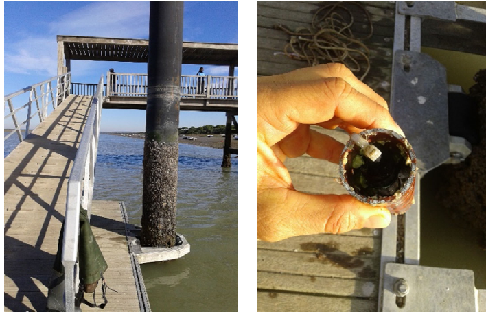
Figura 13: Datalogger utilizado como mareógrafo. Izquierda: embarcadero del río San Pedro (Puerto Real, Cádiz). Derecha: detalle de datalogger en tubo protector.
