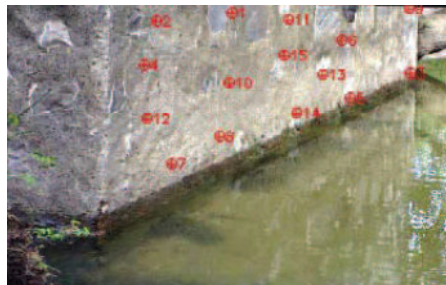
Figura 19: Detalle de fotografía time-lapse del río Guadares con los puntos de control considerados.
