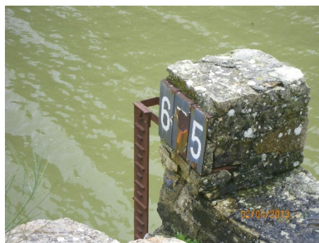
Figura 15: Regleta limnimétrica ubicada en el embalse de Montejaque.
