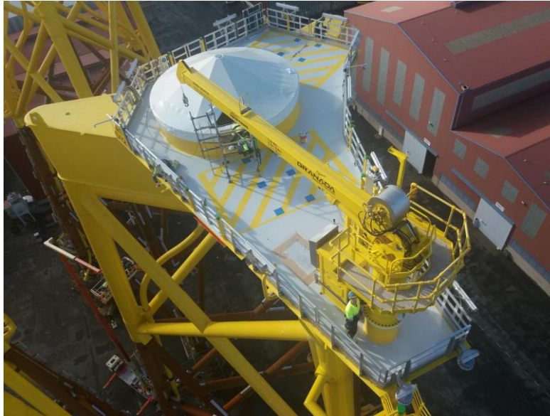
Figura 35: Pieza de transición de las jackets del proyecto EA One [9]
