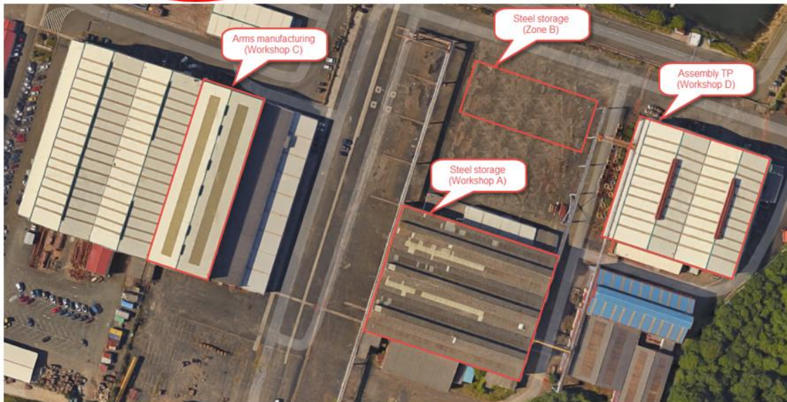
Figura 36: Situación de los talleres de fabricación de TPs en lo talleres de IMENOSA, Fene [11]
