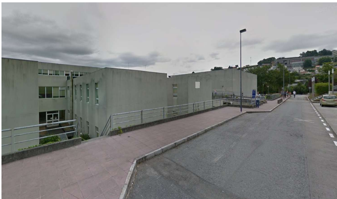
Imaxe 8: Fachada suroeste. (Fachada traseira) Fonte: https://www.google.es/maps
