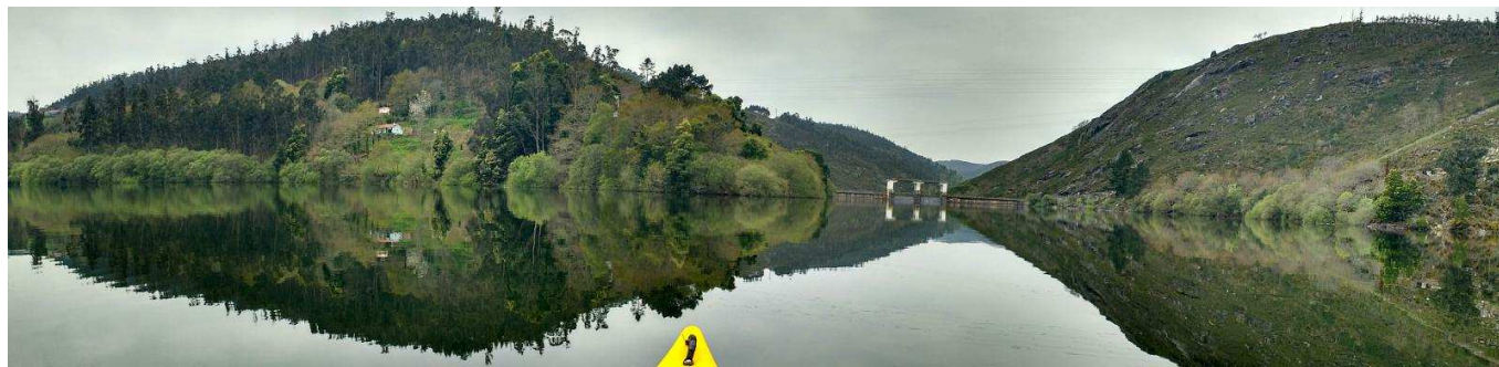
Imagen 5: Vista hacia delante de la siguiente zona de continuación del canal en dirección hacia la presa (aguas abajo), en el embalse Barrié de la Maza. Al fondo se puede ver la presa del embalse. Captura a partir de una fotografía realizada por el usuario "grancalilí" usuario del sitio Wikiloc, donde está dicha fotografía.
