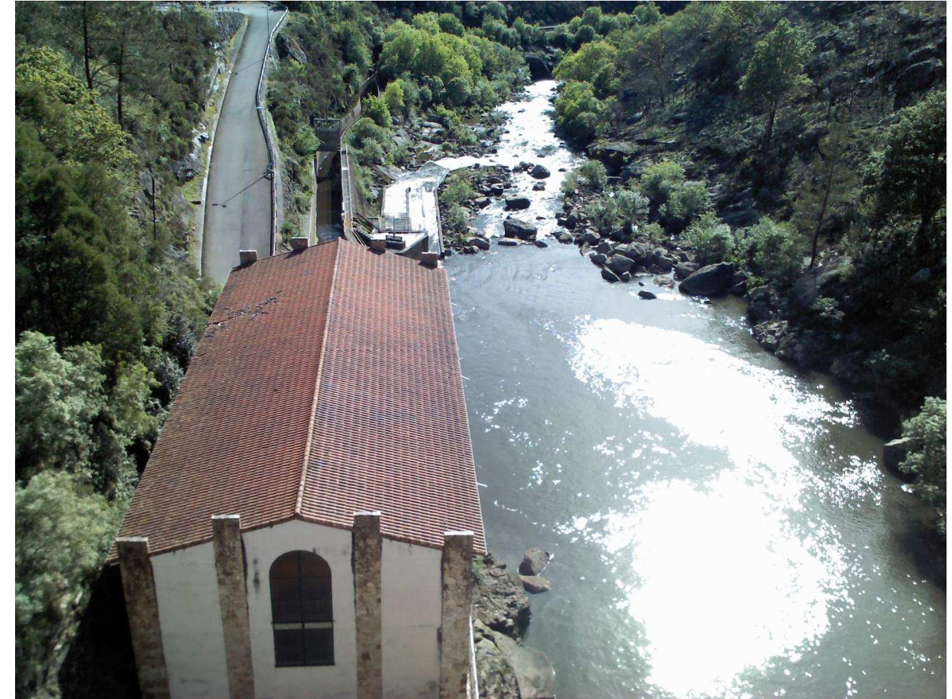
Imagen 14: Vista desde arriba del pie de presa. Fotografía realizada por el usuario "grancalí" usuario del sitio Wikiloc, donde está dicha fotografía.
