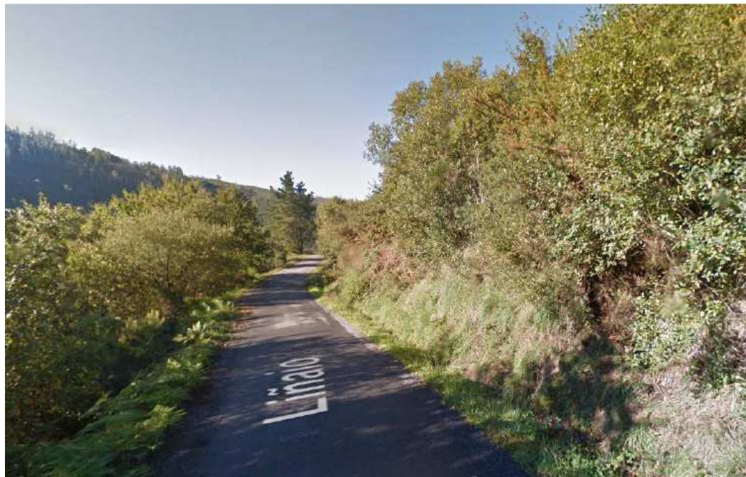
Imagen 9: Vista hacia delante del siguiente punto de actuación del canal desde la carretera liñaio, en dirección hacia la presa. Captura a partir de una fotografía anónima, encontrada en google maps.
