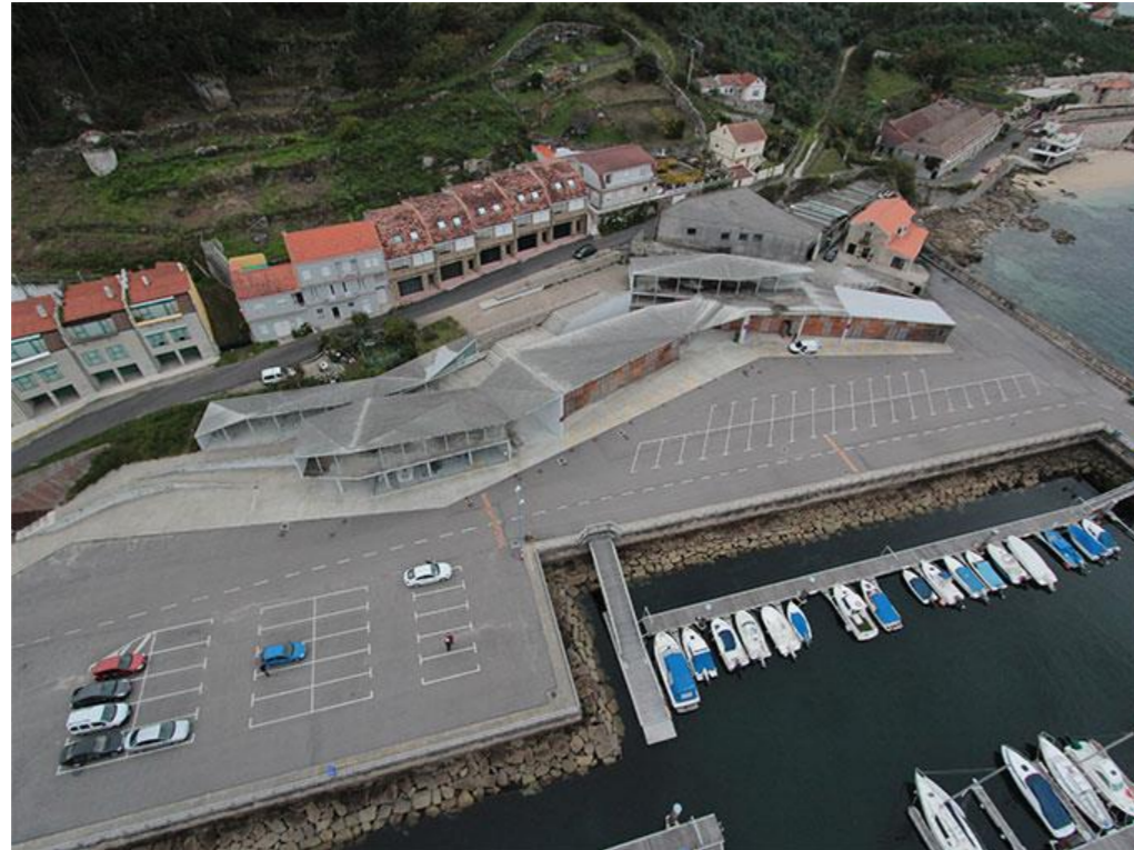
Ilustración 3.- Aparcamiento e instalaciones existentes
