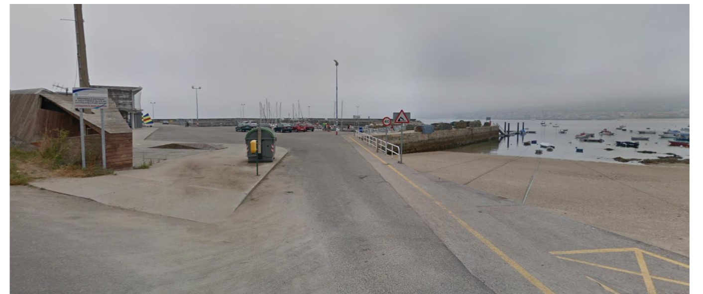
Ilustración 6.- Entrada a instalaciones portuarias
