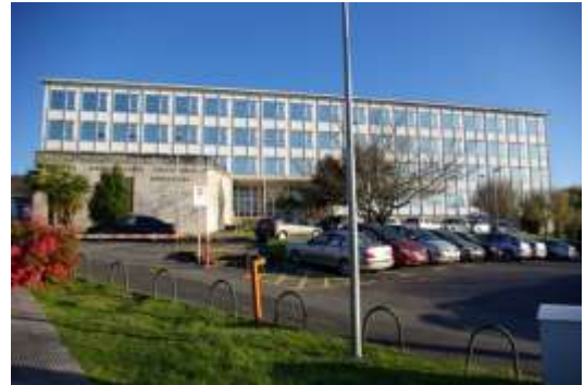
Figura 8-1 Fachada principal de la EUP.
