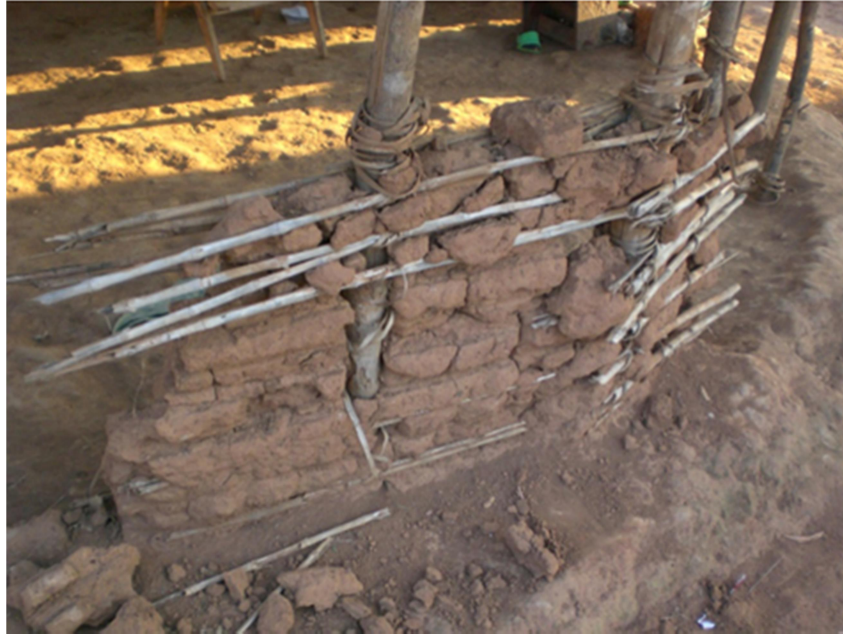
2. Muro de bajareque de una payotte.
