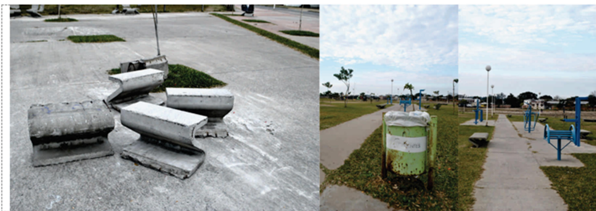
Fig. 8. Equipamiento en mal estado y vegetación deficitaria en el Eco Parque, Corrientes.
