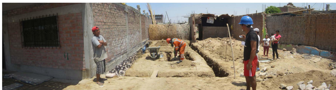
Imagen N° 6 Construcción de módulo de vivienda. Fuente propia.
