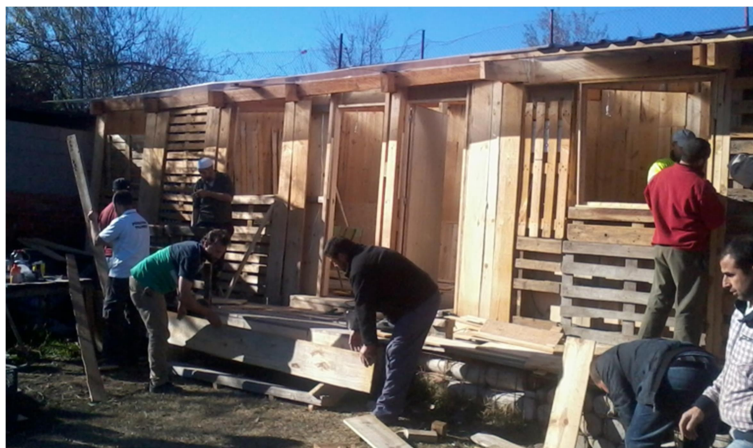
Figura 7: Finalización de la Casita, ampliación de la misma y remates (Diciembre 2014).
