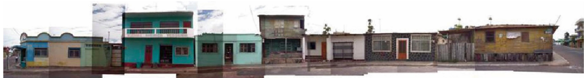
Figura 2. 10-2 _ Arquitectura Popular del “saber hacer”. Fotografías tomadas en Puerto Baquerizo Ayora – Isla San Cristóbal.
