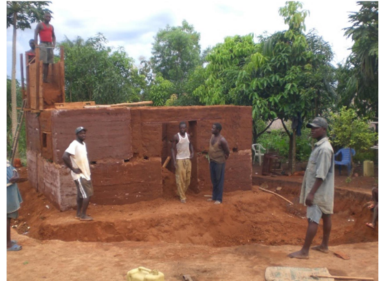
5. Croquis de la propuesta de la investigación de construcción de módulos de tapial junto con un módulo en construcción.
