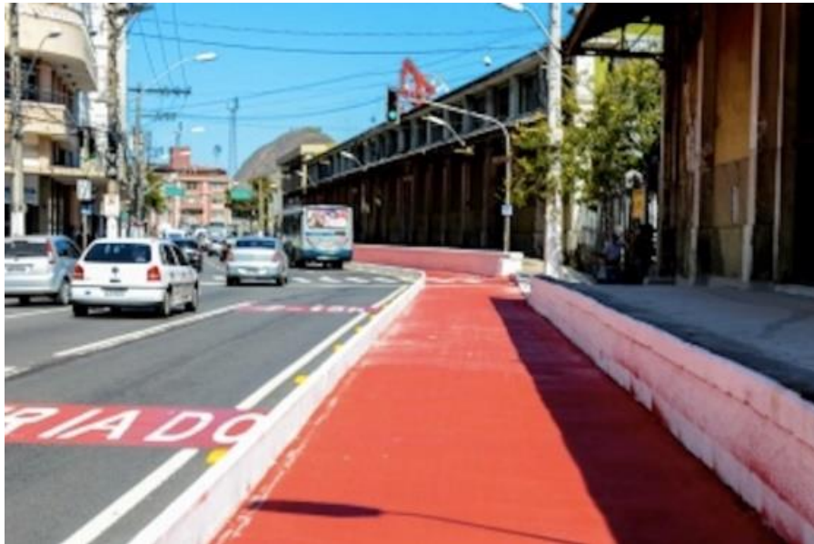
Figura 7 – Registro de conclusão da ciclovia do cais
