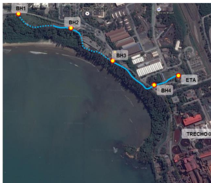
Figura 11 - Vista superior das Barreiras Hidráulicas (BHs) localizadas na Praia de Camburi
