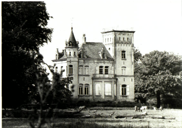
▼ Het pittoreske, neomiddeleeuwse "Château de Huyenhoven" naar ontwerp Antoine Trappeniers vóór de verbouwing, in een verwaarloosd park (foto R. Deneef, 1976)
