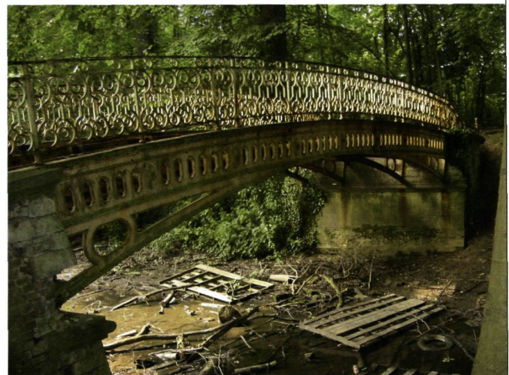
▲ De gietijzeren boogbrug (foto R. Deneef, 2003)
