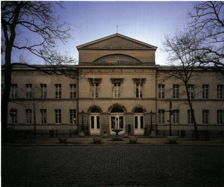
◀ Front situated in the Grootgods- huisstraat (photo O. Pauwels)
