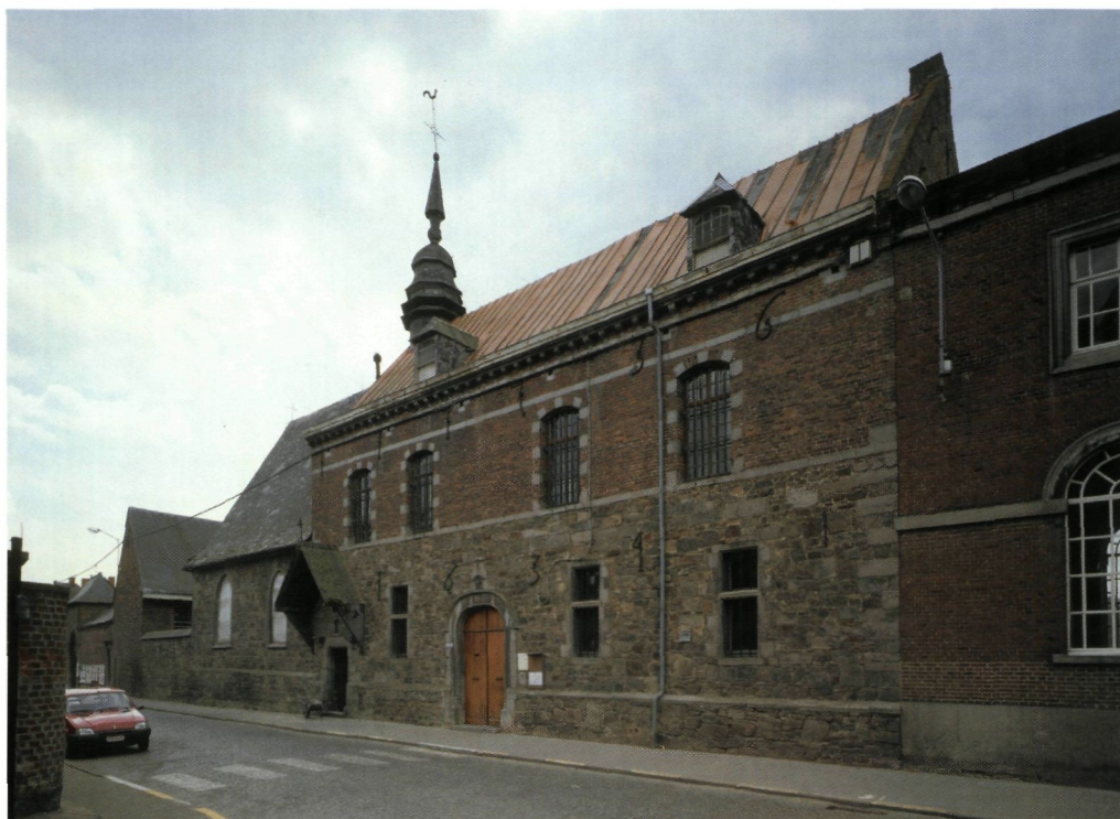
◀ Straatgevel van het hospitaal Saint- Jacques in Le Roeux (foto G. Focant © MRW)
