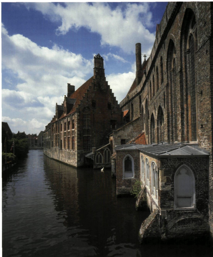
▲ Zuidgevel van de middeleeuwse ziekenzalen en van het zusterklooster van het Sint-Janshospitaal in Brugge (foto O. Pauwels)
