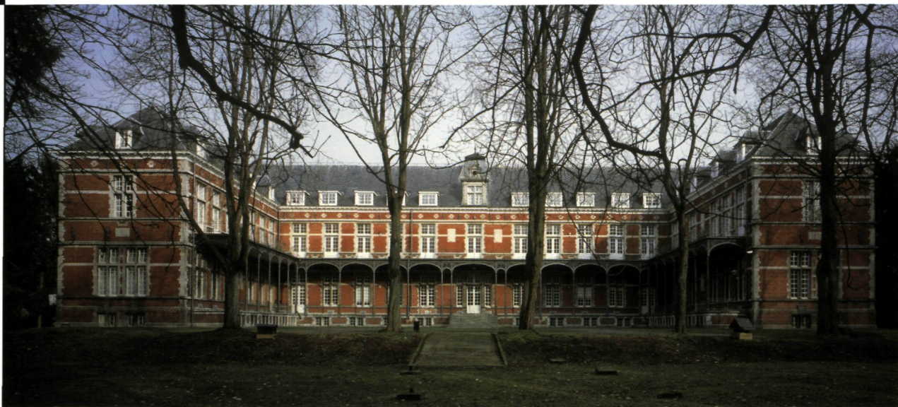
▲ Achtergevel van het hospitaal Latour de Freins in Brussel (foto O. Pauwels)
