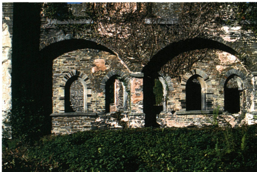
► Oostelijke muur van de infirmerie van Villers (© THOC)
