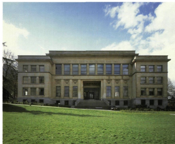
▲ Tandheelkundig instituut George Eastman (1935) van architect Michel Polak in Brussel (foto K. Vandevorst)
