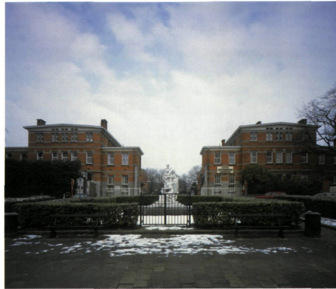
▲ Hoofdingang van het Brugmannhospitaal in Brussel (foto O. Pauwels)
