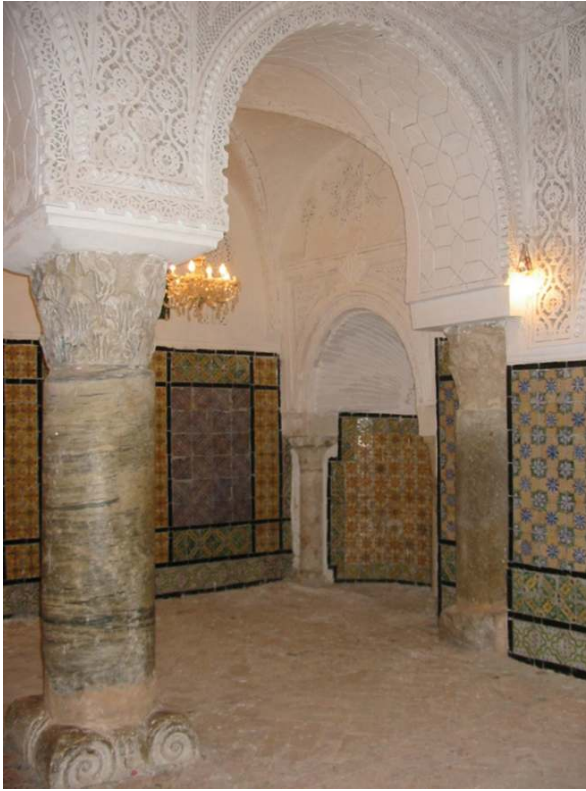
Fig. 5 Zaouïa Sidi Bou Makhoul (Zāwya Sīdī Bū Maḥlūf) du Kef (Kāf) : chapiteau en guise de base.
