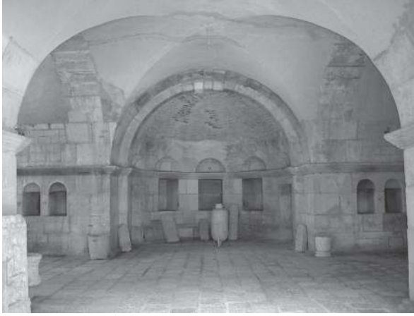
Fig. 12 Salle à auges réutilisée dans une mosquée au Kef.
