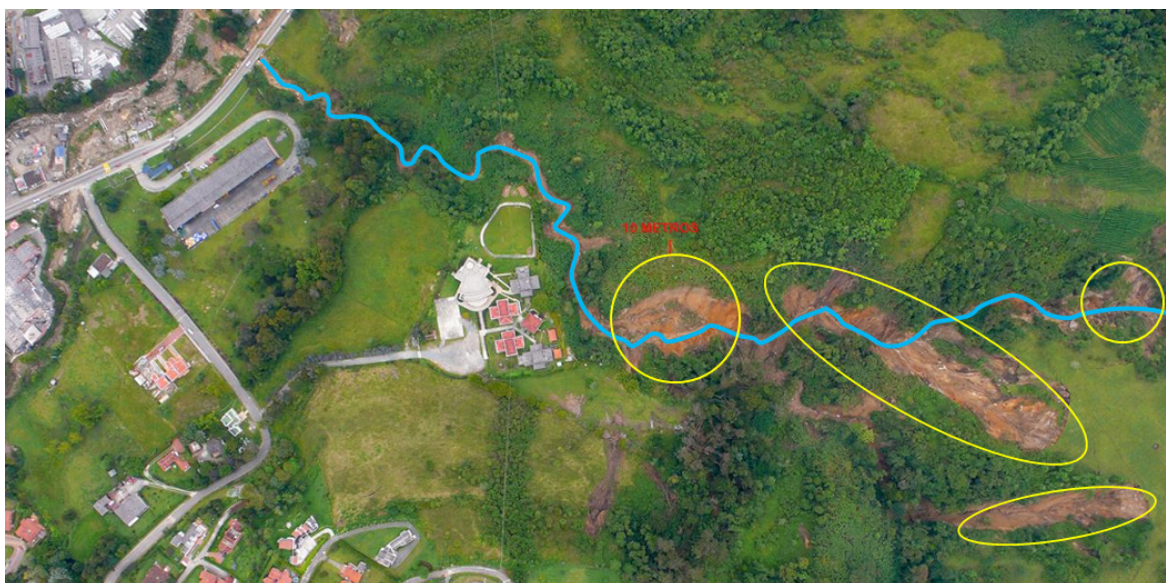
Figura 35. Flujo de lodos. Informe definitivo sobre “Geología para estudios geotécnicos tramo puente la libertad - Potro Rojo Carretera “Honda - Manzales”. Geólogo Eugenio Duque Escobar .Fotografía Miguel A. Aguilar G. 2008.
