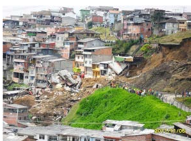
Figura 34. Una combinación de fuerzas de la naturaleza y deficiencias en la infraestructura de agua. Ocasiono la muerte de 48 personas en Manizales. Fotografías Arq. Constructora Tatiana Cardona.2011.
