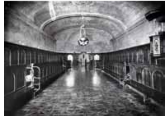
Fig. 6. A l'esquerra, la nova Sala Capitular reformada per Santiago Marco; a la dreta, l'antic espai (Arxiu fotogràfic de Montserrat, Col·lecció Garcia Fuentes).
