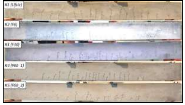
Şekil 13. Yerdeğiştirmenin L/250 değeri için kirişlerdeki çatlak dağılımı
