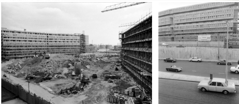
FIG. 34 Fotografies de Robin Hood Gardens en construcció. © Alison Smithson. RIBA Library Photographs Collection.
