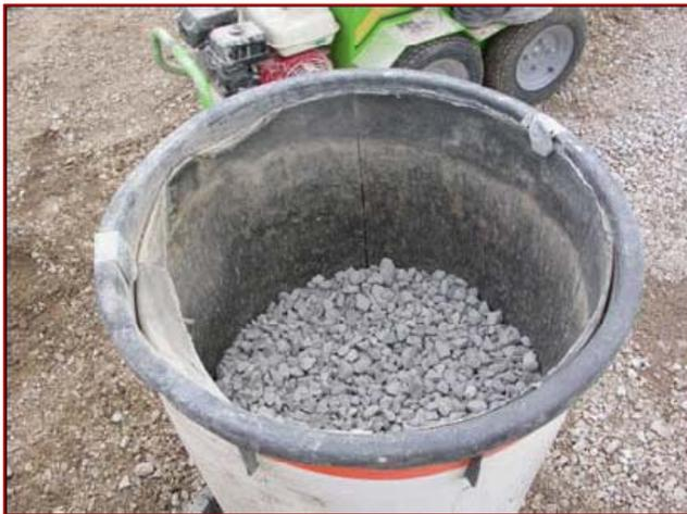
**Figura 4.4** Gravas del fondo del contenedor para asegurar el drenaje
