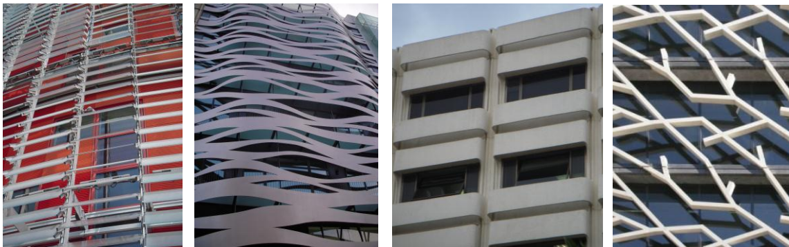
Elementos de control solar
