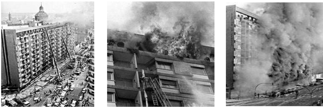
Fig. 3.5 Imágenes del incendio del hotel Corona de Aragón Zaragoza 12 de julio de 1979.
