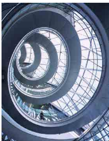
Fig. 3.49 Vista del atrio y la rampa desde la cámara de asambleas. Fuente: Arup Fire
