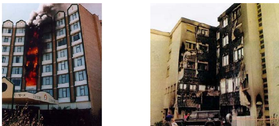
Fig. 3.17 Incendios en edificios plurifamiliares con propagación a través de la fachada. (A) Propagación a través de las ventanas. Franja de material incombustible + alero pequeño. Country confort Motel Australia 1998 (B) Propagación a través del aislamiento térmico combustible. Alemania 1996. Fuente: Martin – Loncour, 2004
