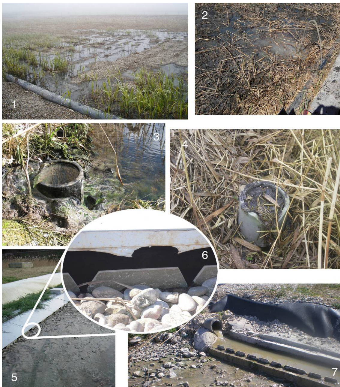
Figura 1.13 Sistemas de distribución del afluente. 1 tubería perforada; 2 tubería perforada; 3 tubería vertical; 4 tubería vertical obstruida; 5 canal de distribución; 6 detalle; 7 canal de distribución.
