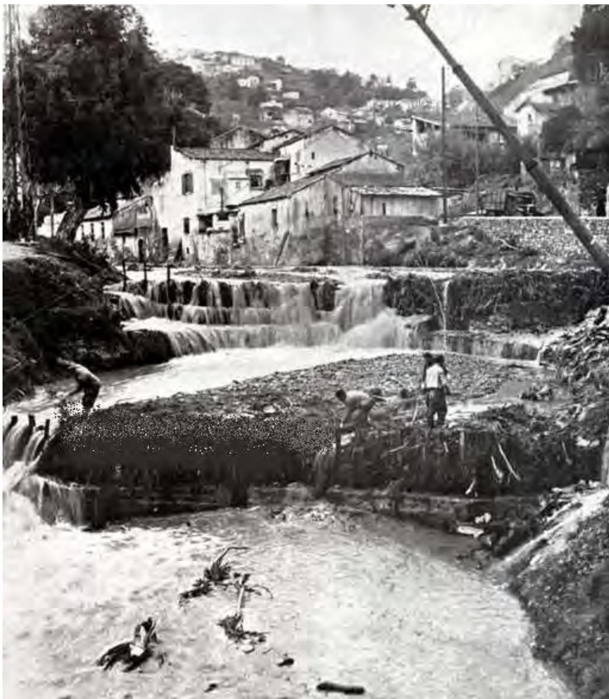
Voici une vue de la tête amont du collecteur M'Kacel après un gros orage (danger pour les égouts). On peut remarquer sur la droite l'énorme masse de débris retenus. D'où la nécessité de barrages de protection. (362)
