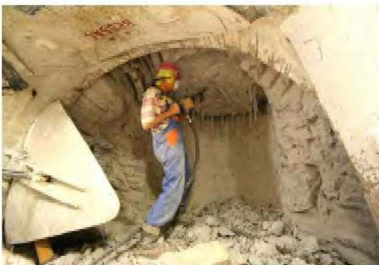
Pointe Pescade: demolición manual de un pilote
