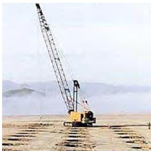
Foto mostrando la técnica de consolidación dinámica 213
