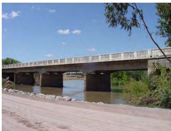
Figura 2. 22. Vista general puente San Luis.
