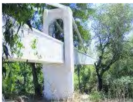
Figura 1. 1. Puente atirantado de Tempul.
