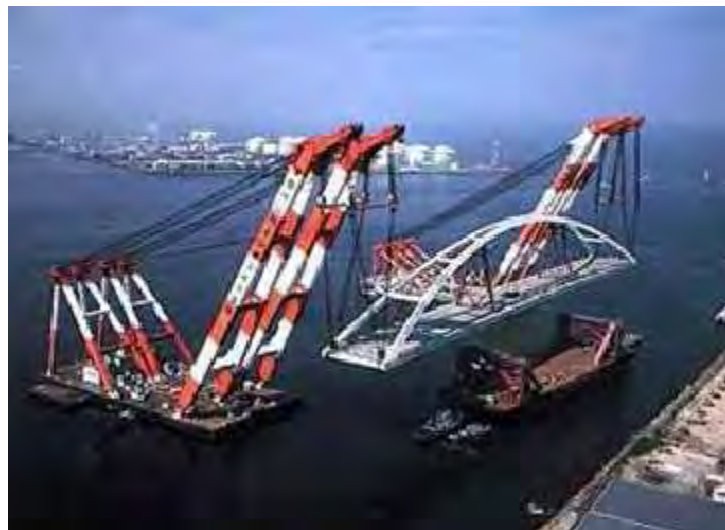
Figura 3. 2. Montaje por alzamiento del puente Shinhamadera, Japón. [Tveit, P. (2007)].
