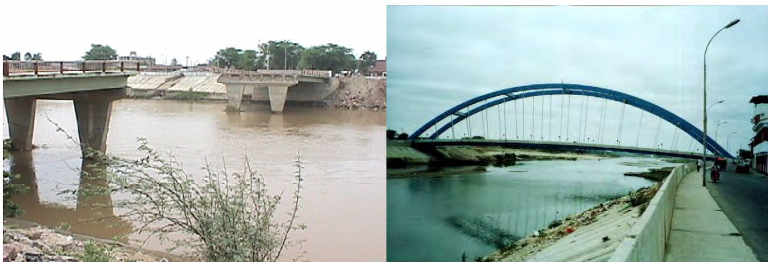
Figura 1. 3. Puente Bolognesi: Colapso y reemplazo.
