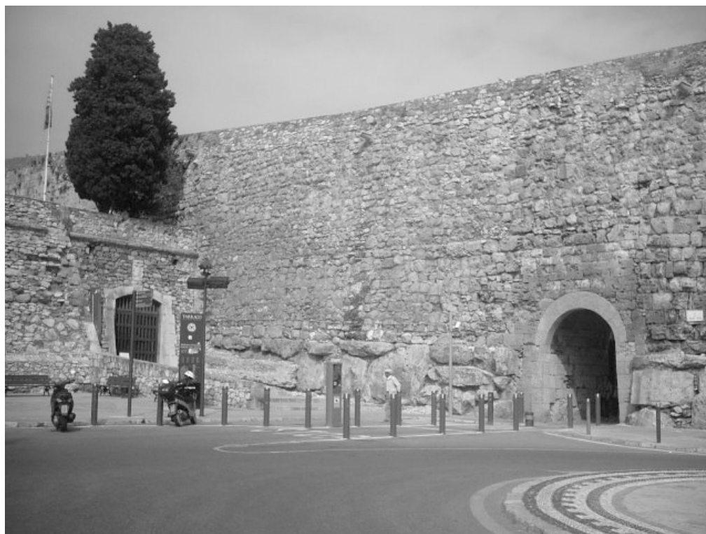
Vista exterior de la muralla a la altura del Portal del Roser (fotografía: Miguel Alonso).
