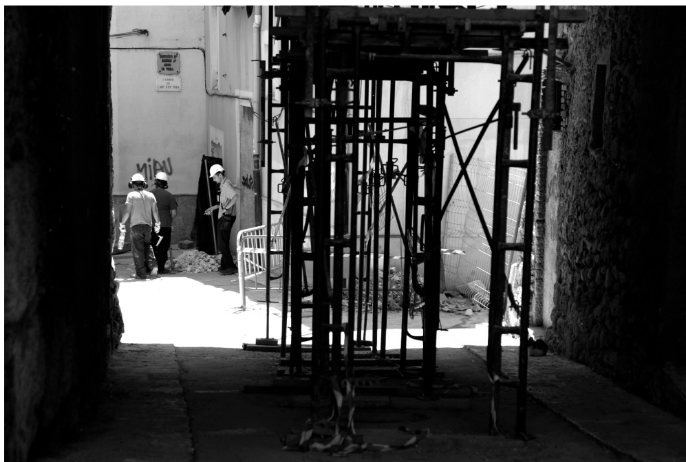
Instantánea en la que se puede observar el andamiaje que, desde principios de 2011, sostiene la estructura del Arco d'en Toda. Al fondo el responsable y los operarios de las obras de construcción del futuro Centro Cívico Can Agapito, que estará ubicado en el solar a la derecha del mismo arco (cortesía de María Vesses Ferrer).
