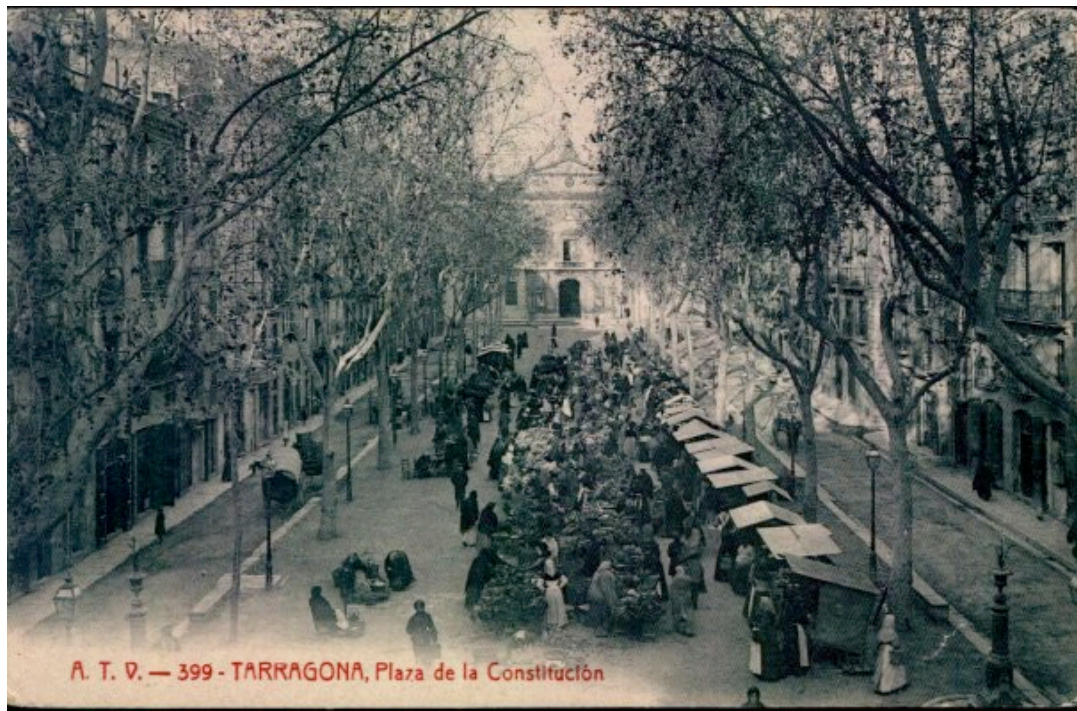
Fotografía IV: Plaça de la Font, 1900-1910, autor desconocido (fuente: foro Tarragona Antiga)
