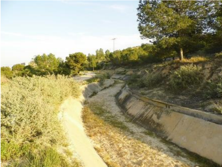
Foto 2. Tramo del canal construido en 1992 (2ª fase).
