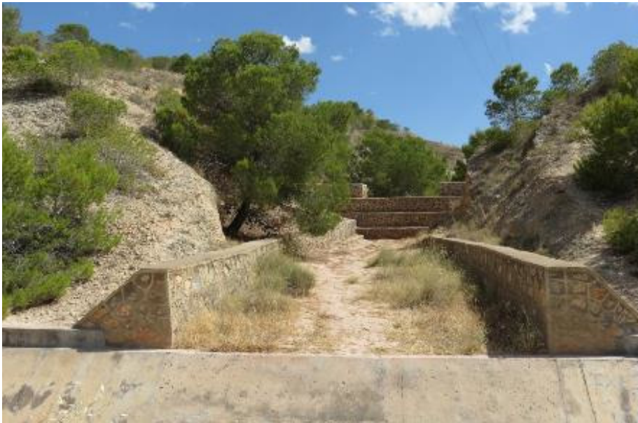
Foto 6. Encauzamiento del tramo final de uno de los barrancos en su entronque con el canal de avenamiento.
