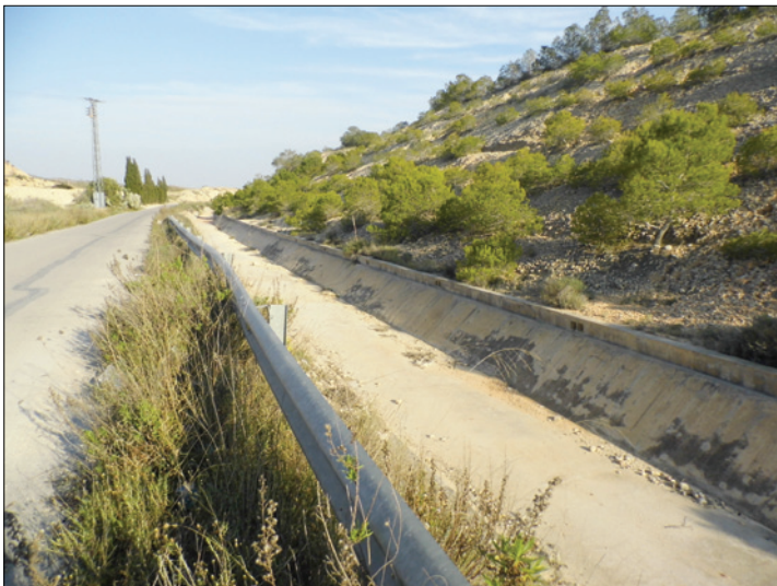
Foto 1. Tramo del canal construido en 1991 (1ª fase).
