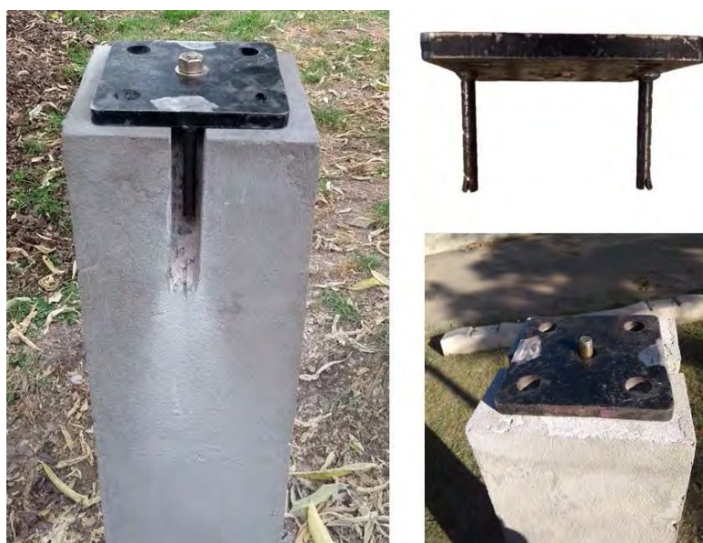
Figura 5: Placa de coronamiento y pilar.
