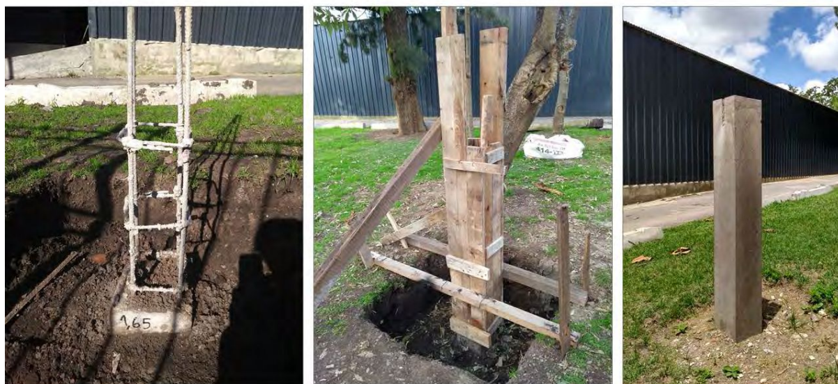
Figura 4: Diferentes etapas en la construcción de los tres pilares.
