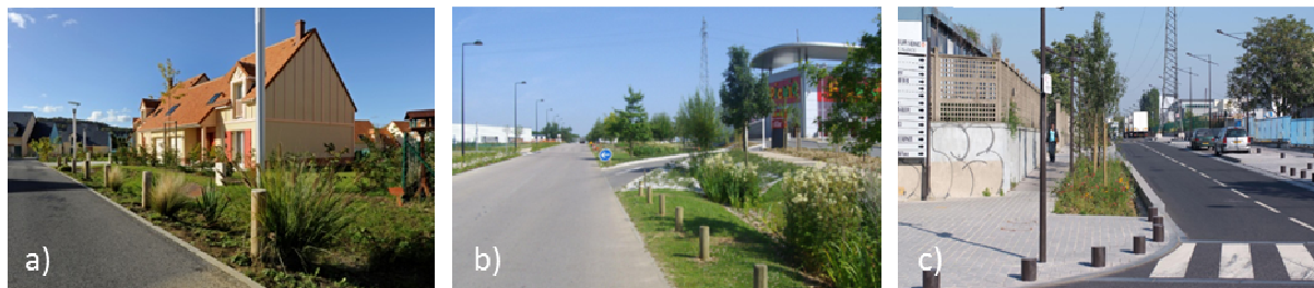
Figure 1 : Exemples de noues qui reçoivent les eaux de voirie par ruissellement latéral. (a) dans un quartier d'habitation, (b) dans une zone commerciale, (c) en milieu urbanisé dense. Photos : INFRA Services
