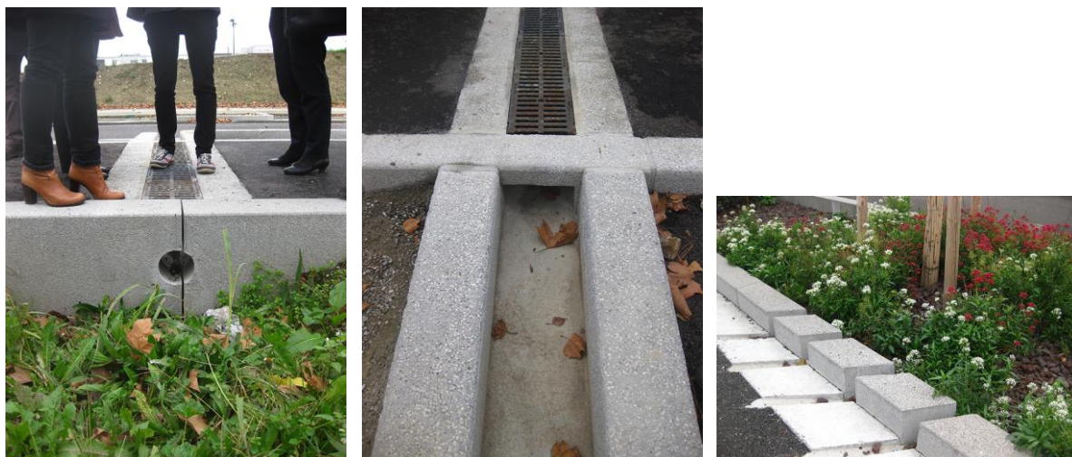
Caniveaux et murets ajourés pour passage de l'eau (photographies décembre 2014 et octobre 2015 – Eranthis paysagiste)
