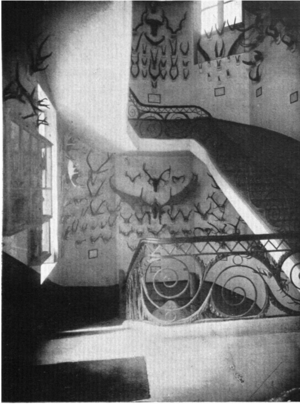
L'escalier (XVIII e siècle).
