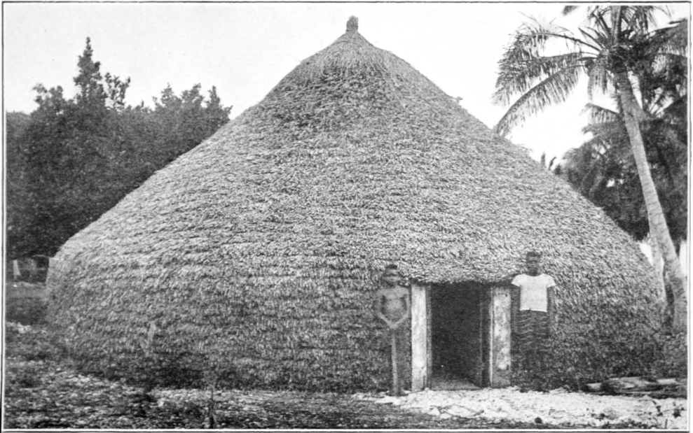
Case ronde à Maré (archipel des Loyalty) en feuilles de canne à sucre. Cloisons épaisses, absence de sculptures.
